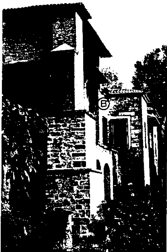
FOTOGRAFIA 8 - CONTRAFUERTE RECONSTRUIDO -
