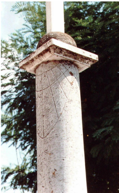
Figura 7a - Detalle de la cornisa cuadrada (no original), las líneas horarias y las líneas de calendario del reloj de sol de Latronico (Italia) (Fotografía: Lucio Saggese. Sundial Atlas: http://sundialatlas.net )
