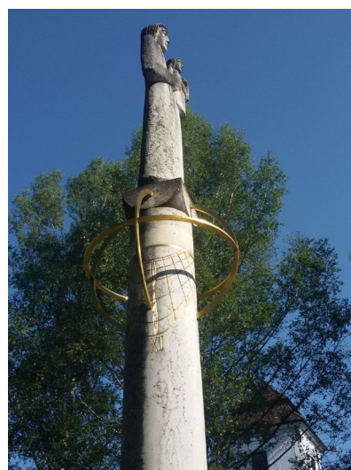
Figura 10b - Detalle del “sombbrero” - formado por un aro y otros arcos de soporte – y de la línea horaria del mediodía con la curva de tiempo medio grabada en la columna mariana en el Monasterio de “Marienmünster” (Alemania) (Fotografía: Fabio Savian. Sundial Atlas: http://sundialatlas.net )
