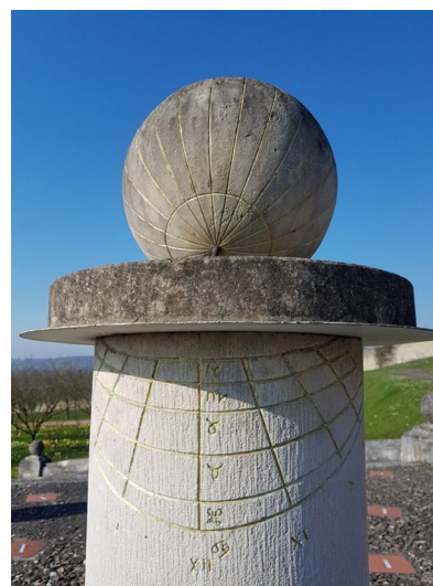
Figura 5b - Detalle del “sombrero” y de la red de líneas horarias y de calendario del reloj de sol de Saint-Martin-de-Boscherville (Francia) (Fotografía: Véronique Haugel)
