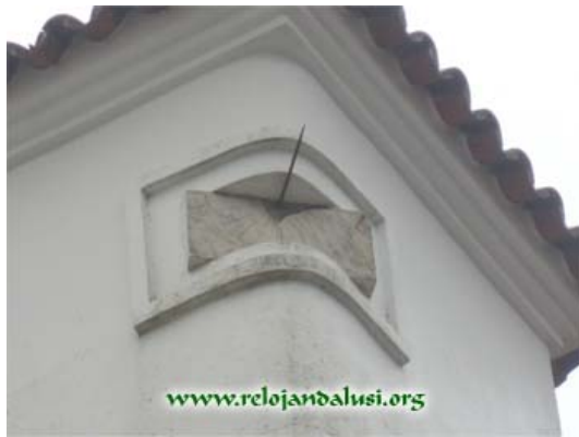
Fig. 19. Casa de la Inquisición de Aracena, trazado de horas iguales, limbo semicircular. Foto: Ignacio Garzón
