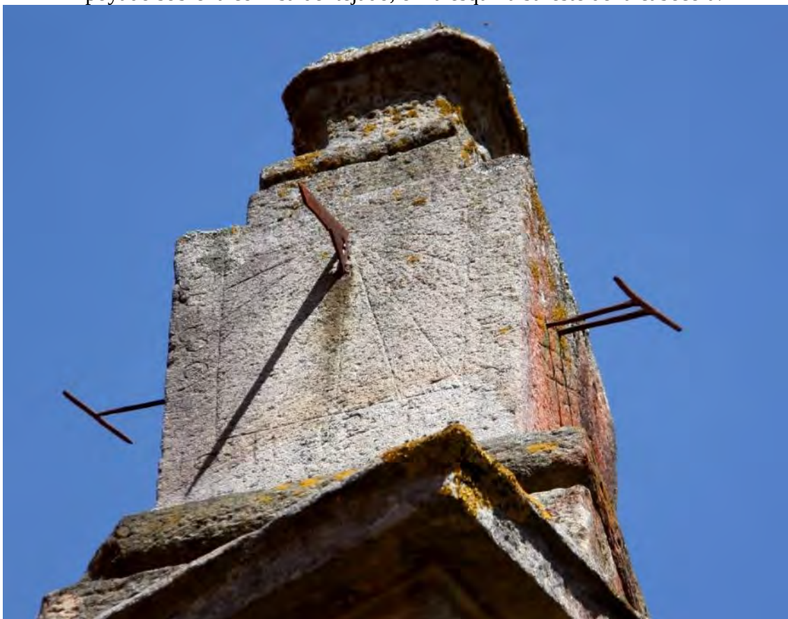
Reloj de sol triple orientado: VM, VL y VP. Conserva las varillas originales.
