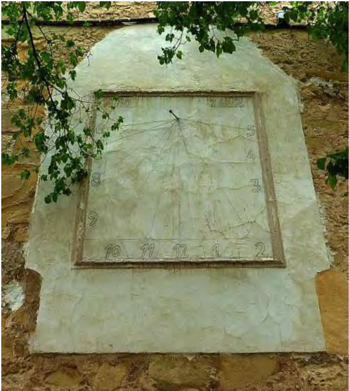
Marco rectangular doble con el rectángulo exterior moldurado. Sin superficie de distribución. Horas en números arábigos, de 6 de la mañana a 5 de la tarde. Algunas líneas horarias no convergen en el polo. Varilla de un apoyo terminada en una bolita. Fecha grabada en la parte superior: Año 1882.
