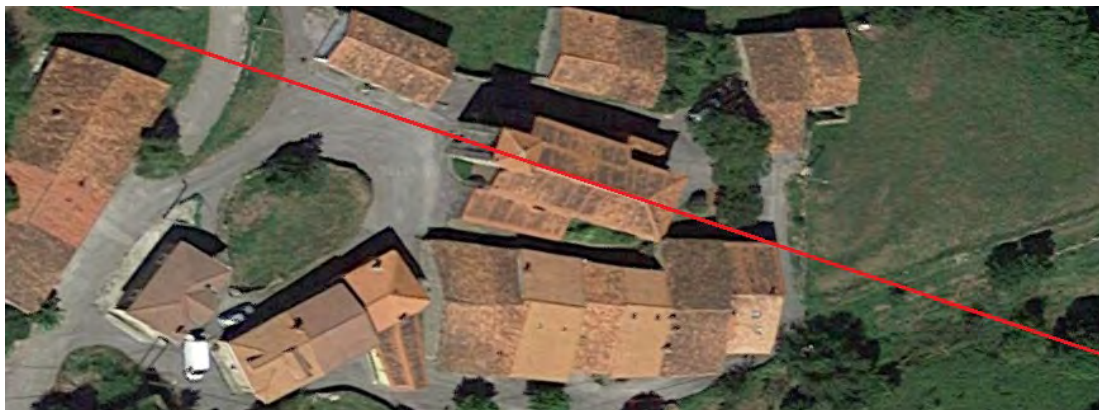
La fachada principal declina 18° a poniente. El reloj de sol está mal orientado.
