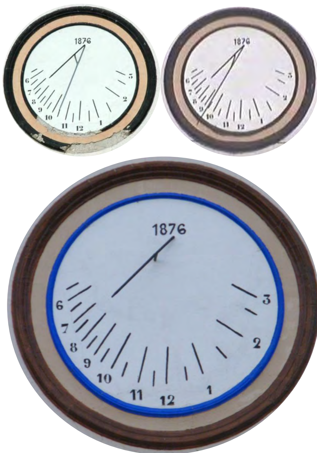
Reloj de sol radial pintado en el interior de un marco circular moldurado de yeso, situado entre los dos balcones de la tercera planta de la casa del estanco. Horas en números arábigos, de 6 de la mañana a 3 de la tarde(marca a partir de cinco y media de la mañana). Las líneas horarias no convergen en el polo. Líneas más cortas de medias horas. Varilla de dos apoyos en 'Y'. Fecha pintada sobre el polp del reloj: 1876.
