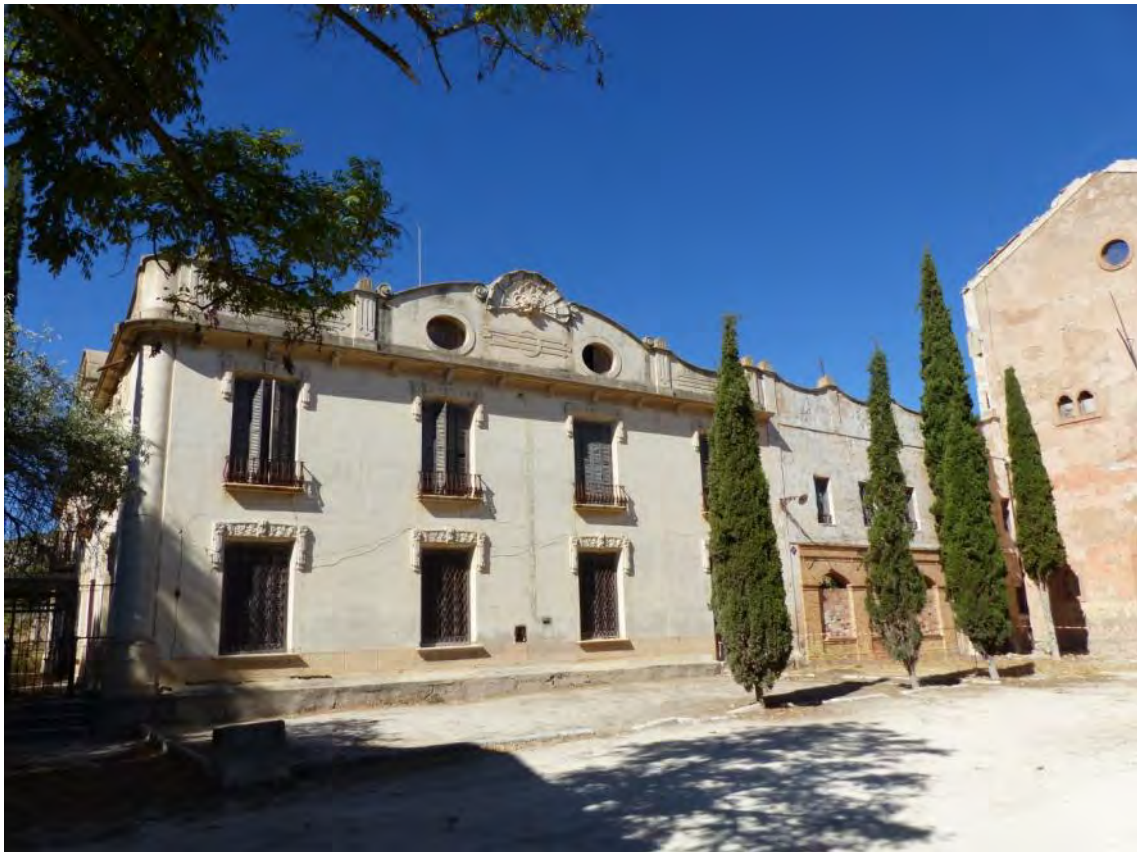
El palacio y la fábrica de alcoholes de la Colonia de Santa Eulalia.
