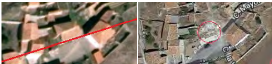
Casa consistorial derribada.
