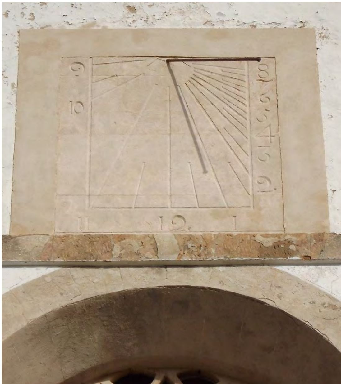
Cuadrante vertical declinante a poniente después de la restauración.
