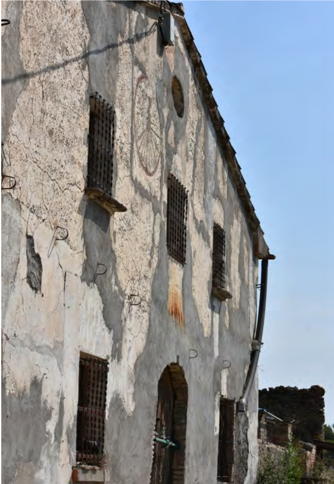
Situado entre la ventanas central e izquierda de la primera planta.
