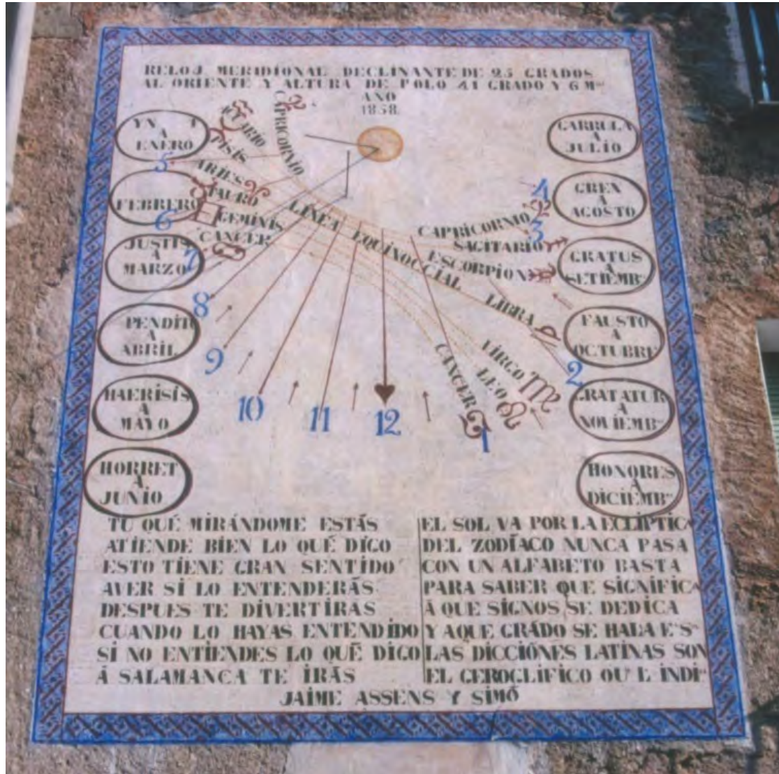
RELOJ MERIDIONAL DECLINANTE DE 25 GRADOS AL ORIENTE Y ALTURA DE POLO 41 GRADO Y 6 M. AÑO 1858
