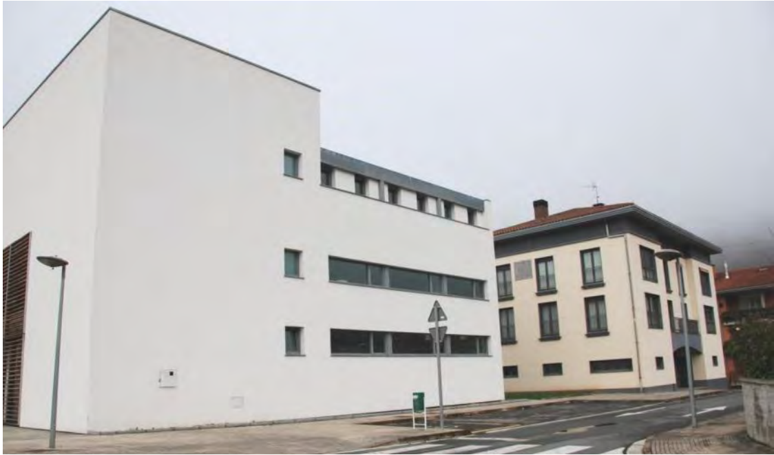
La fachada lateral del edificio del reloj de sol declina 11 grados a levante.
