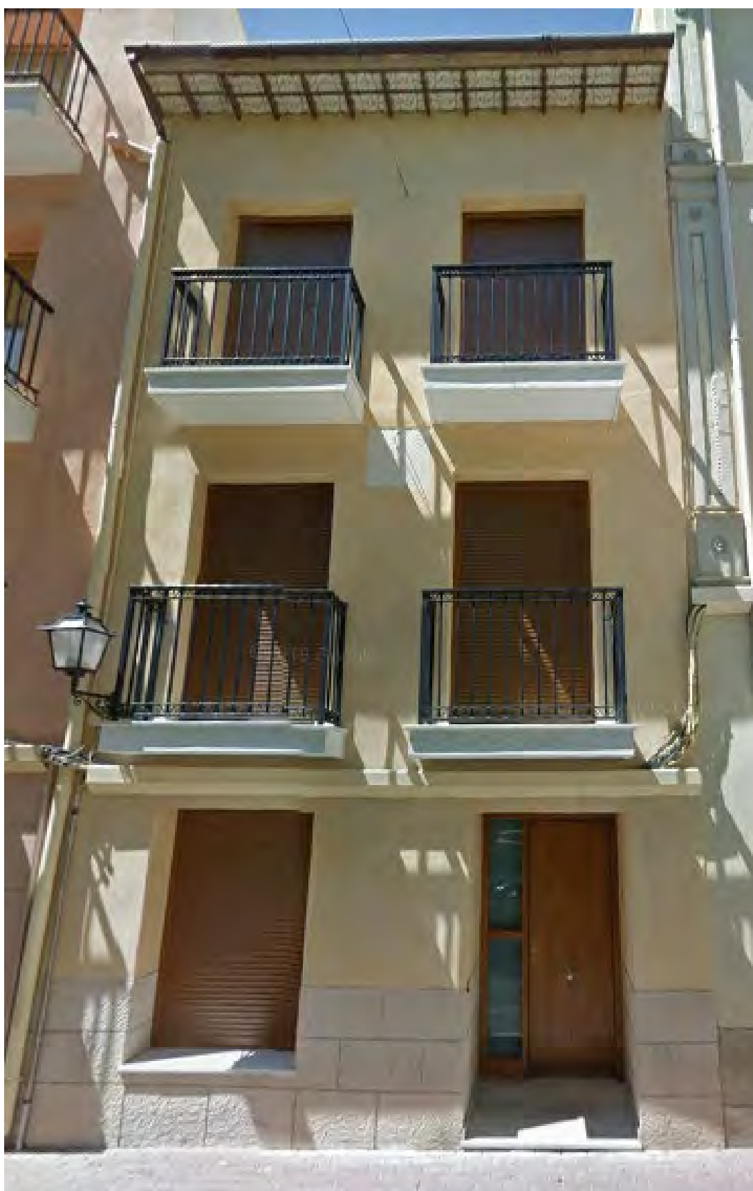
Fachada rehabilitada. Los balcones dan sombra al reloj de sol.
