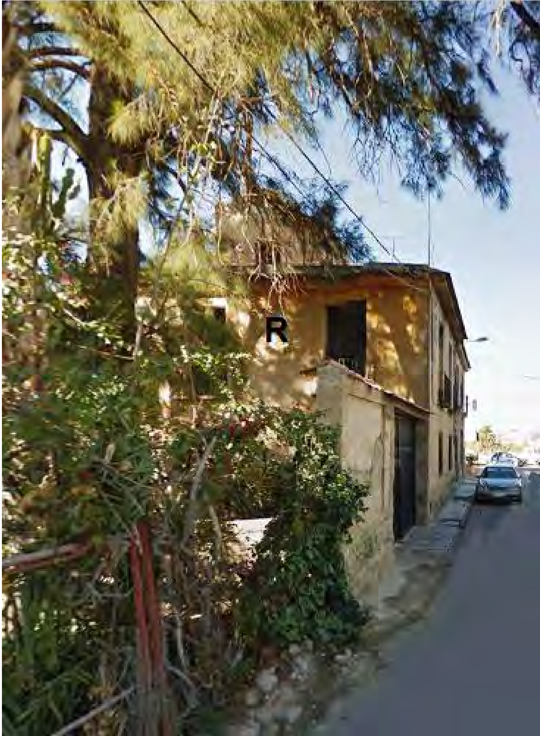
Reloj de sol a la derecha del balcón central. .
