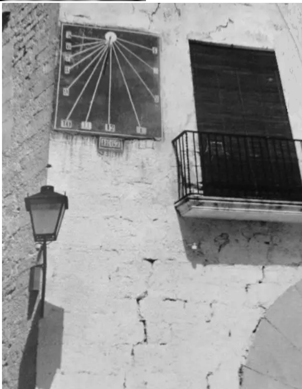
El reloj de sol de la plaza antes de la restauración.
