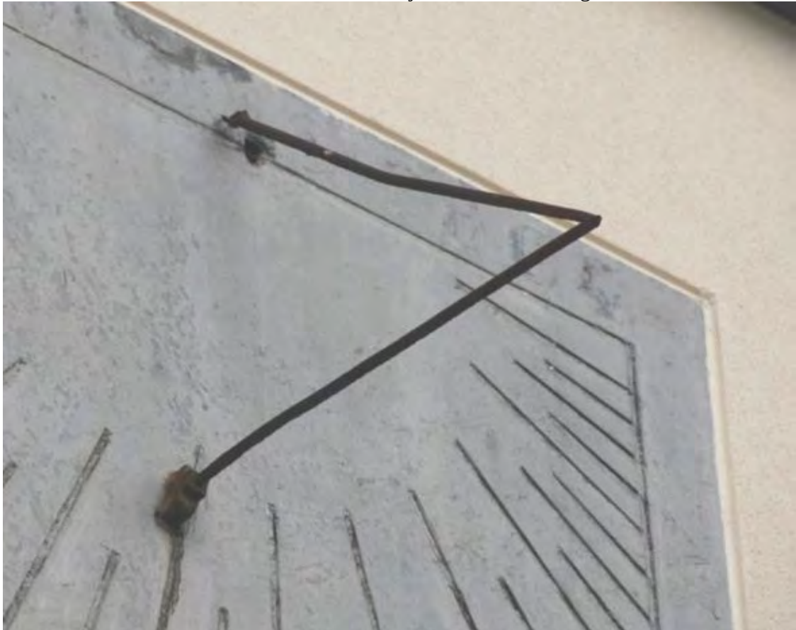
Varilla acodada con el apoyo en el extremo superior de la línea de las doce.
