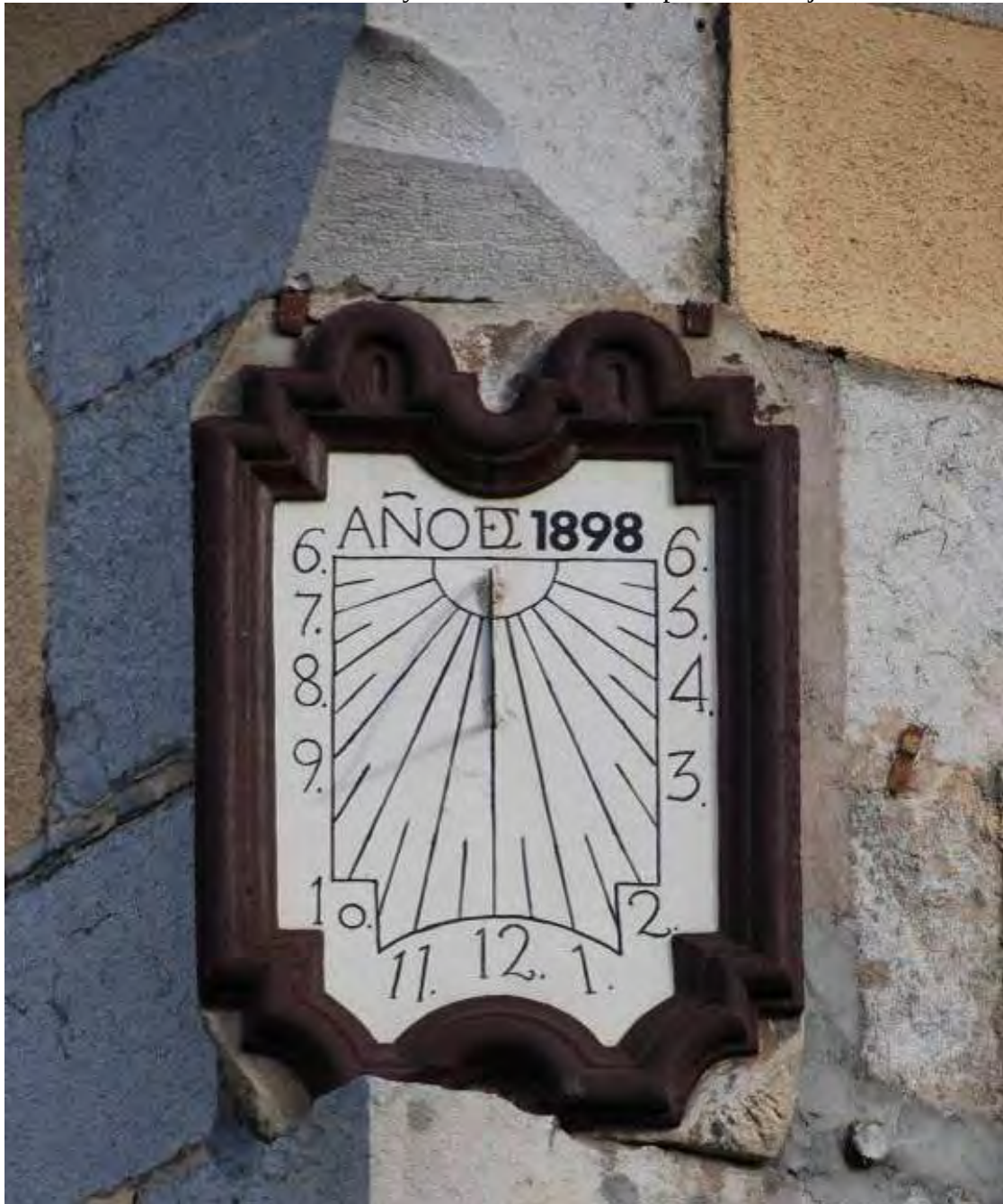
Repintado durante la restauración de la fachada.
