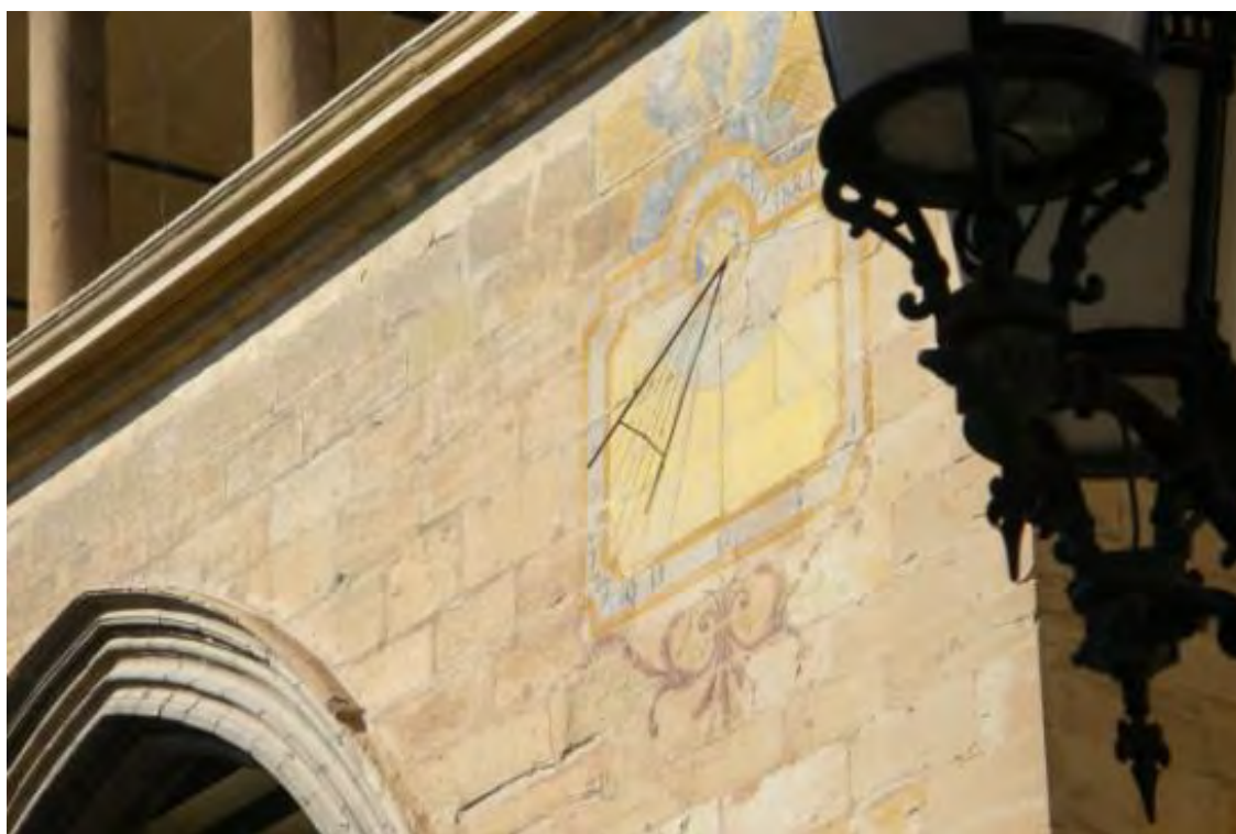
Reloj grabado y pintado en el muro, a la derecha de la arcada de la lonja (s. XV).
