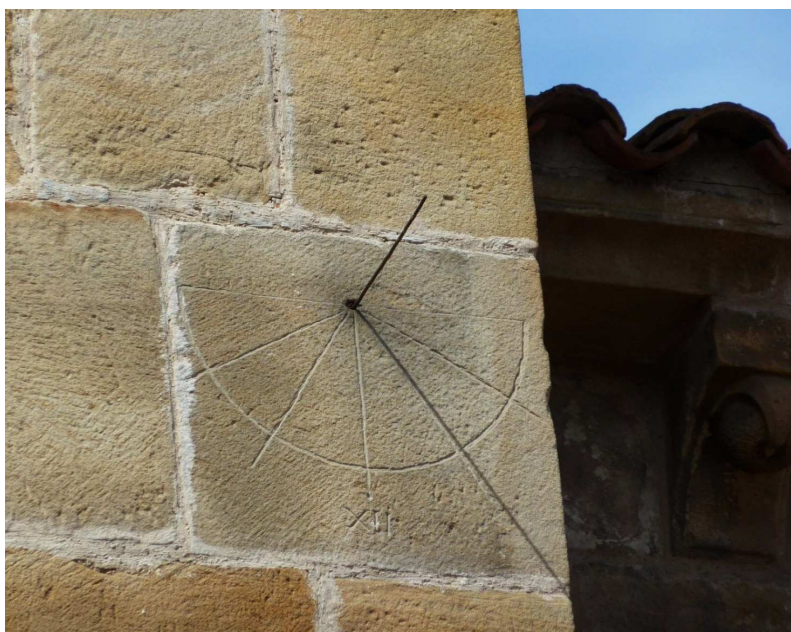
Reloj de sol de horas canónicas (6 x 30°) de Santa María de la Oliva
