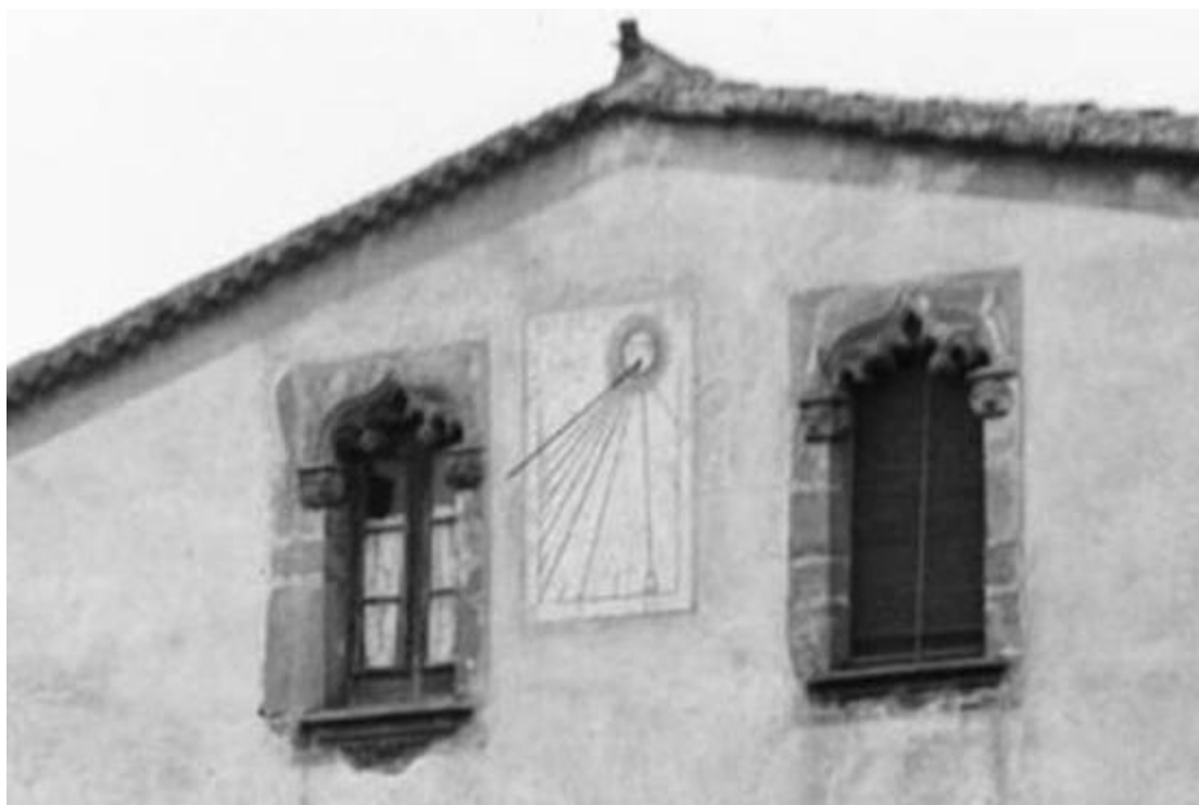
Rectangular. Círculo distribuidor desplazado hacia la derecha. VDL. Marca de seis a dos. La línea de las doce no es vertical. Campanita del Ángelus. Medias horas. Varilla de un apoyo.
