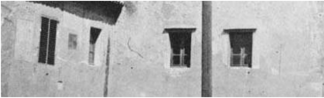
El reloj declinante a levante se encontraba a la izquierda de la ventana.
