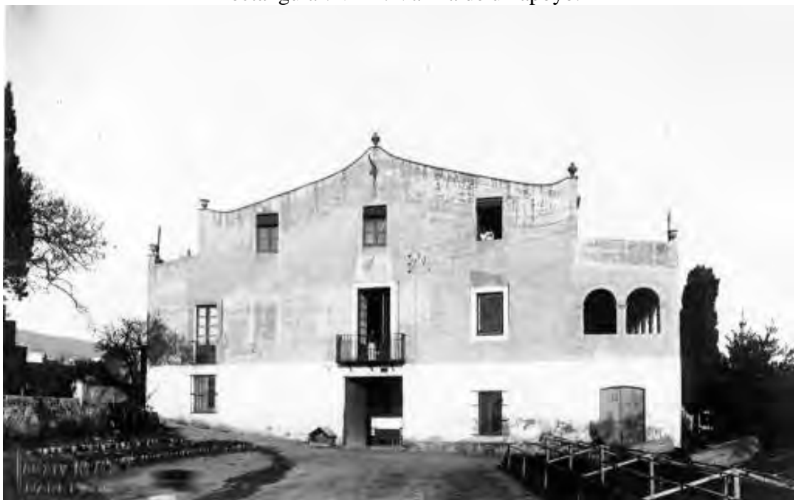
Torre Garcini / Can Ramón d'Alós. Guinardó. Barcelona. Barcelonès. AFCEC 1890-1914. R.
