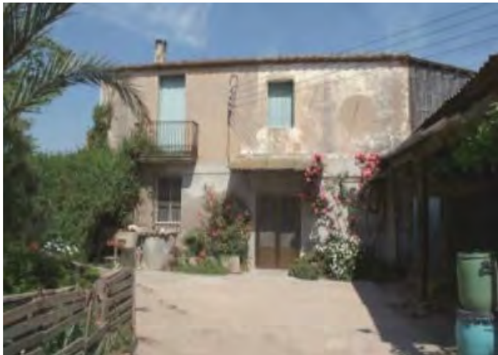
A la façana es veuen les restes d'un rellotge de sol.
