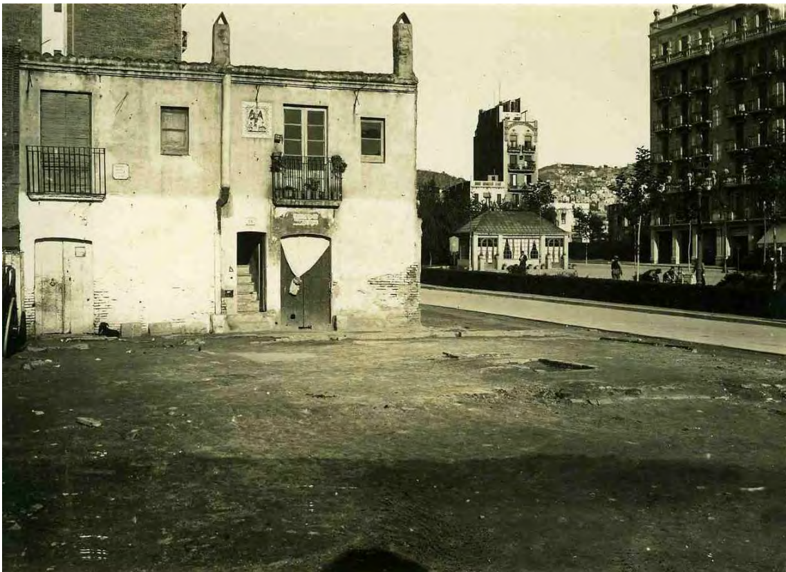
Casa del carrer Sant Isidre. Gràcia. Barcelona. Barcelonès. 1933. D.
