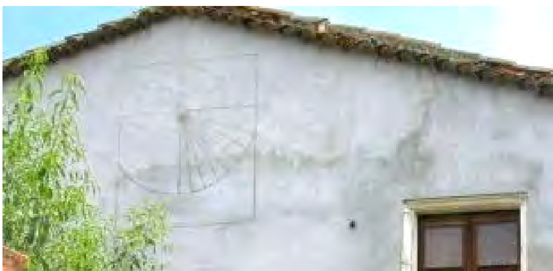
Vertical declinante a poniente. Marca de doce a ocho. Varilla de un apoyo.
