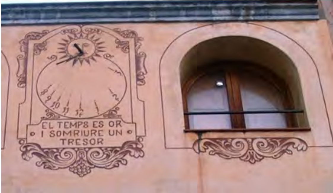
Circular. Marco decorado con motivos vegetales y cueros. Cara de sol decorando el polo. VDL. Horas en números arábigos de 8 de la mañana a 3 de la tarde, escritos en el extremo de las líneas y con un puntito debajo. Varilla de un apoyo. Leyenda en una cartela bajo el reloj: "EL TEMPS ES OR I SOMRIURE UN TRESOR".
