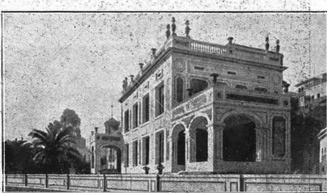
Escuela de la Farigola. Detalle del edificio
