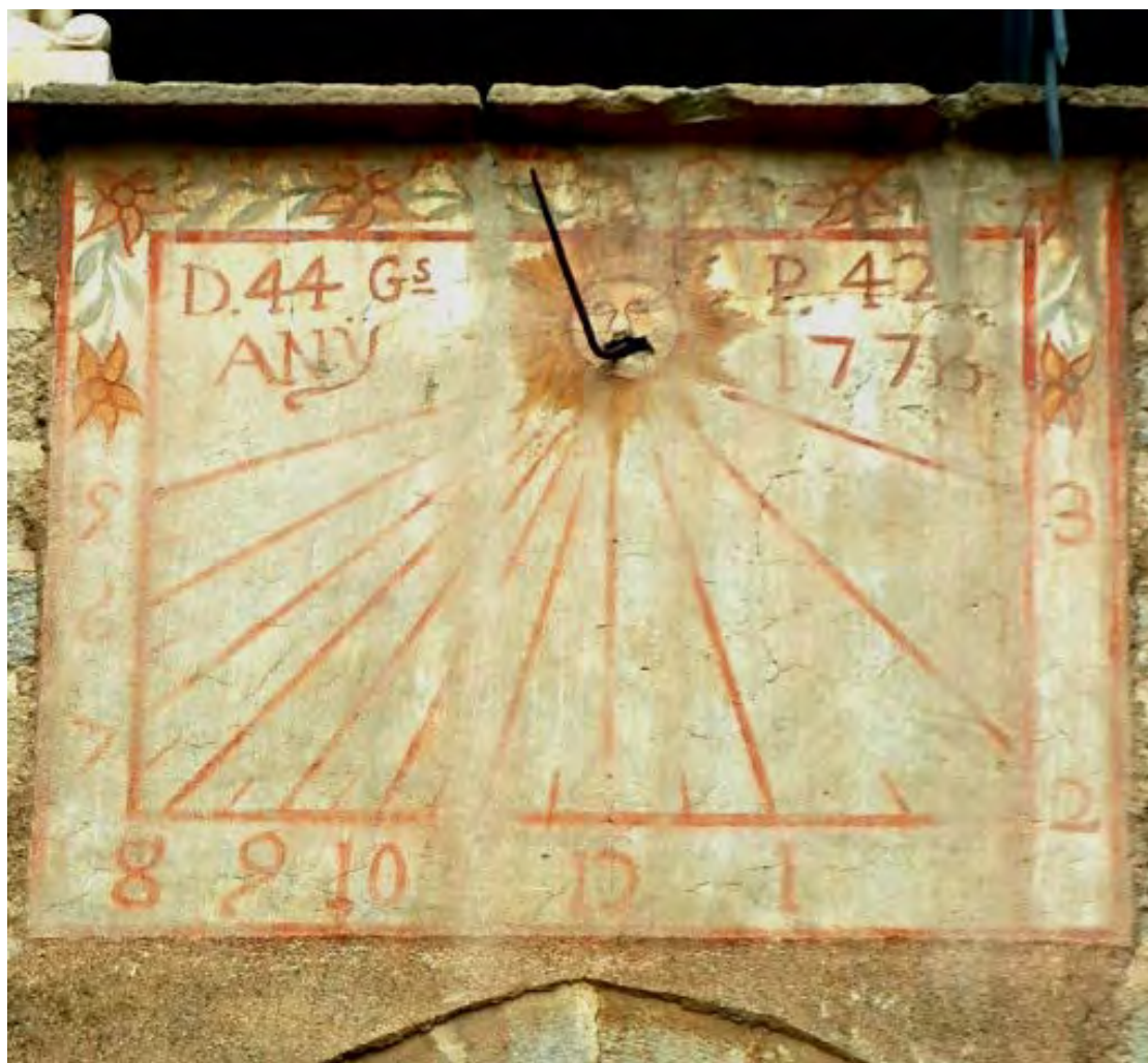
Reloj de sol doble. Cuadrante vertical declinante a levante.
