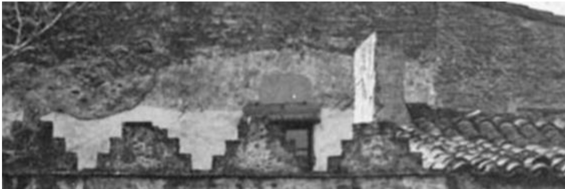
Reloj de sol exento. Raro. Vertical a mediodía. Varilla de un apoyo.
