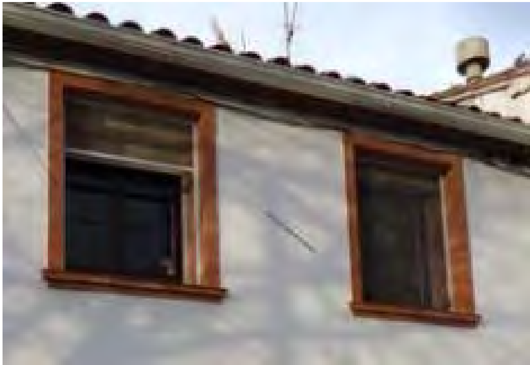
Varilla entre las dos ventanas de la segunda planta.
