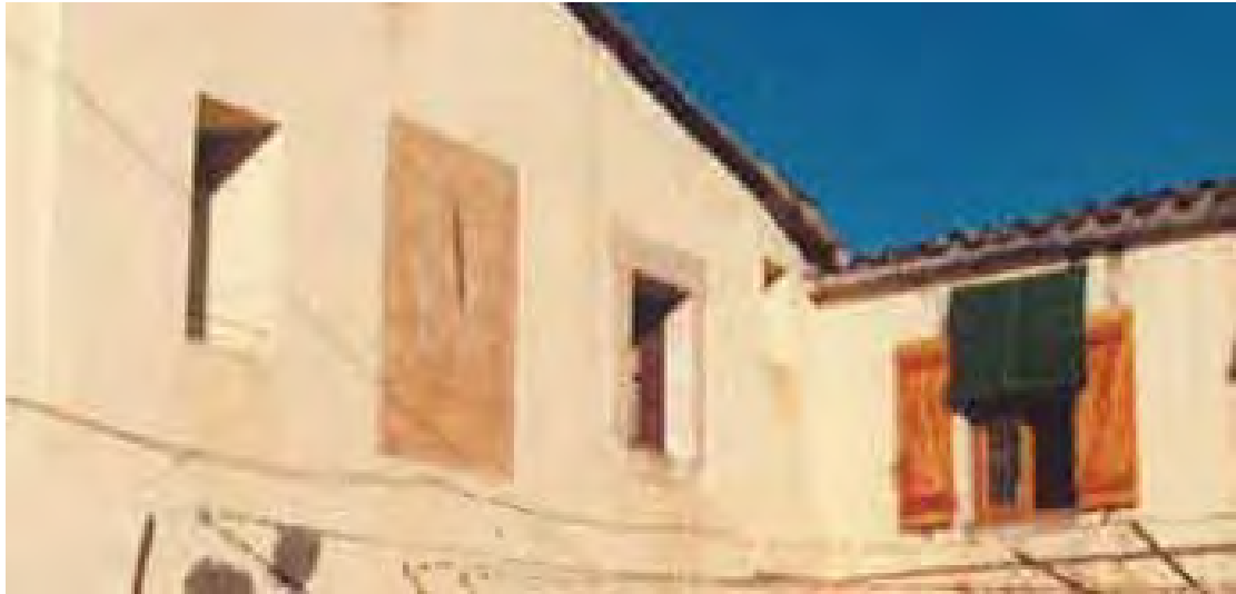
Rectangular vertical. Varilla de un apoyo mal orientada. La fecha del reloj se refiere a un documento de 1571 donde aparece la masía con el nombre de Can Cardona.
