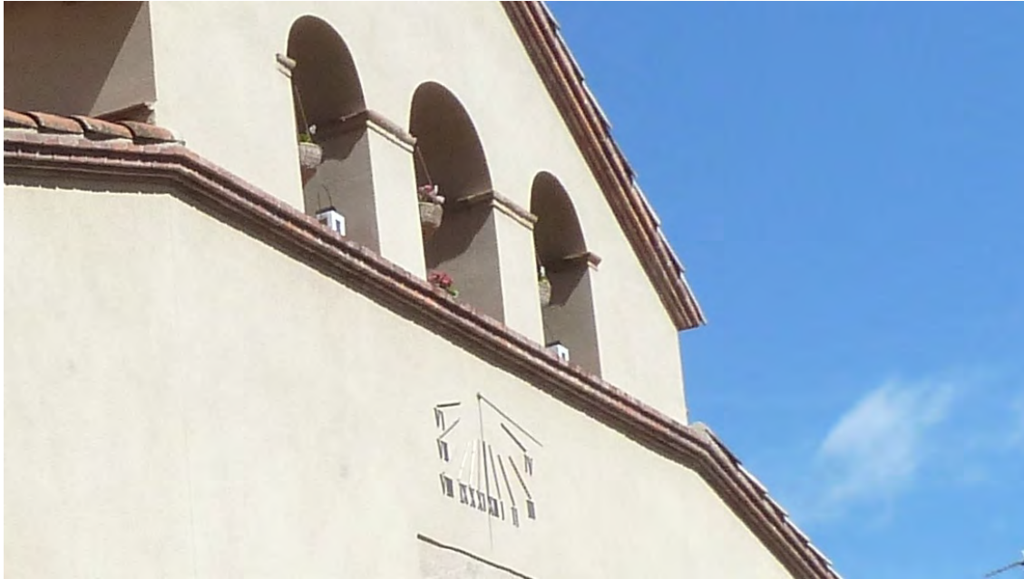
Radial pintado de negro sobre el balcón central. VDL. Horas en números romanos, de VI de la mañana a IV de la Tarde. Varilla de un apoyo.
