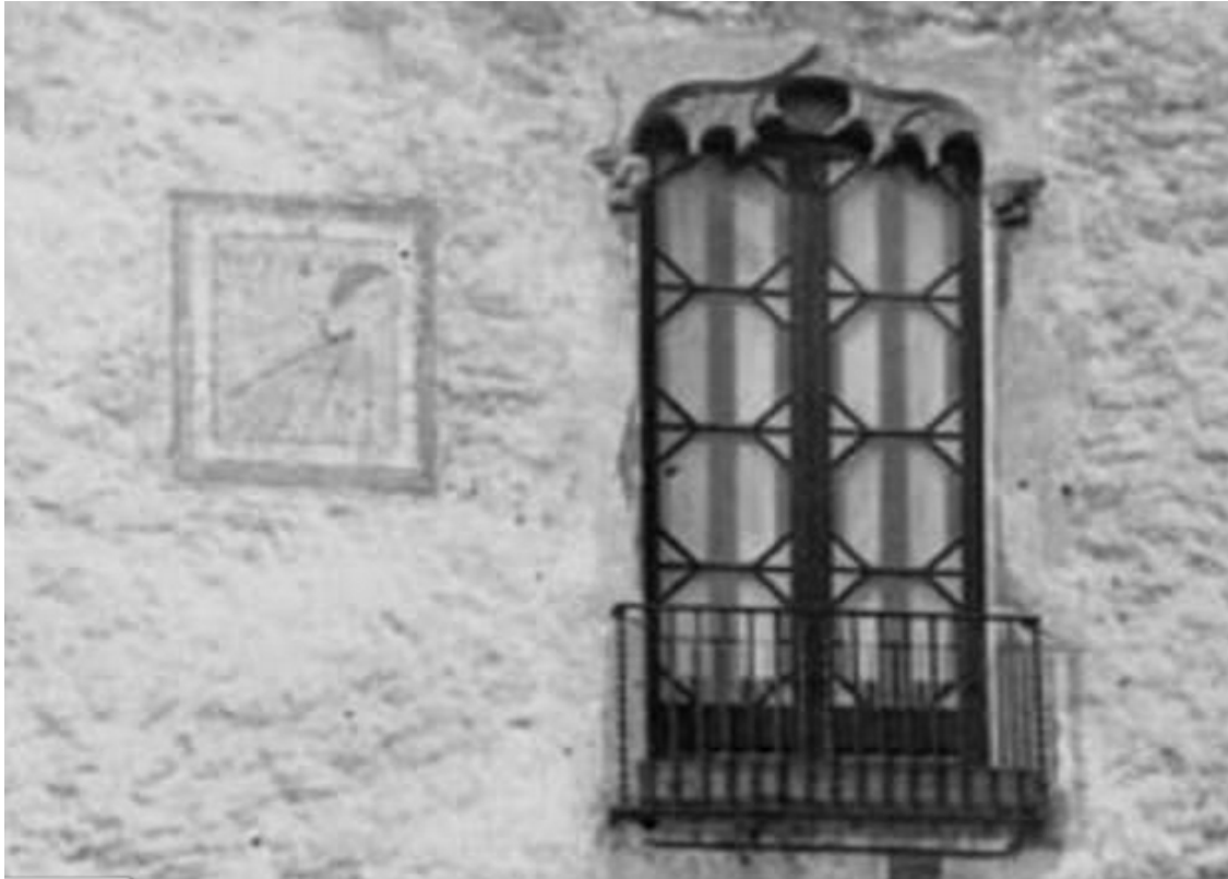
Rectangular. Polo desplazado hacia la derecha. Muy declinante a levante. Posible reloj doble.
