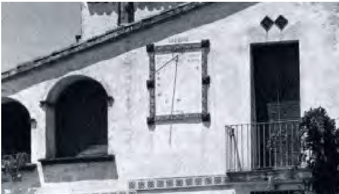
Radial en el interior de un marco rectangular cerámico. VDL. Varilla de un apoyo.
