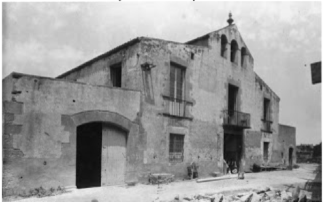
Masia de Sant Martí de Provençals. Barcelona. Barcelonès. AFCEC 1890-1914. D.
