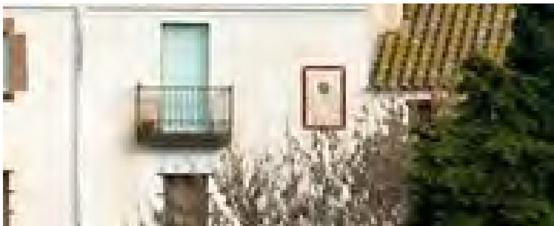
Situado en la parte derecha de la fachada principal, a la altura de la primera planta. Rectangular. Círculo distribuidor.
