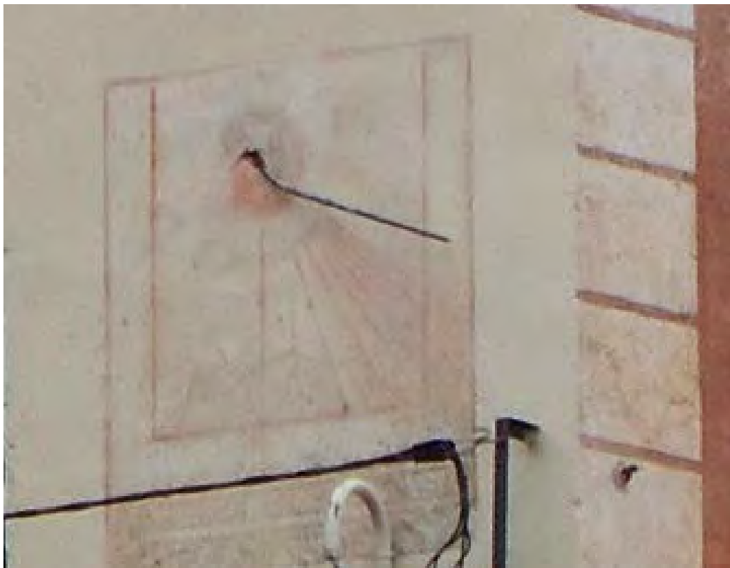
Líneas horarias de once a siete. Varilla de un apoyo doblada.
