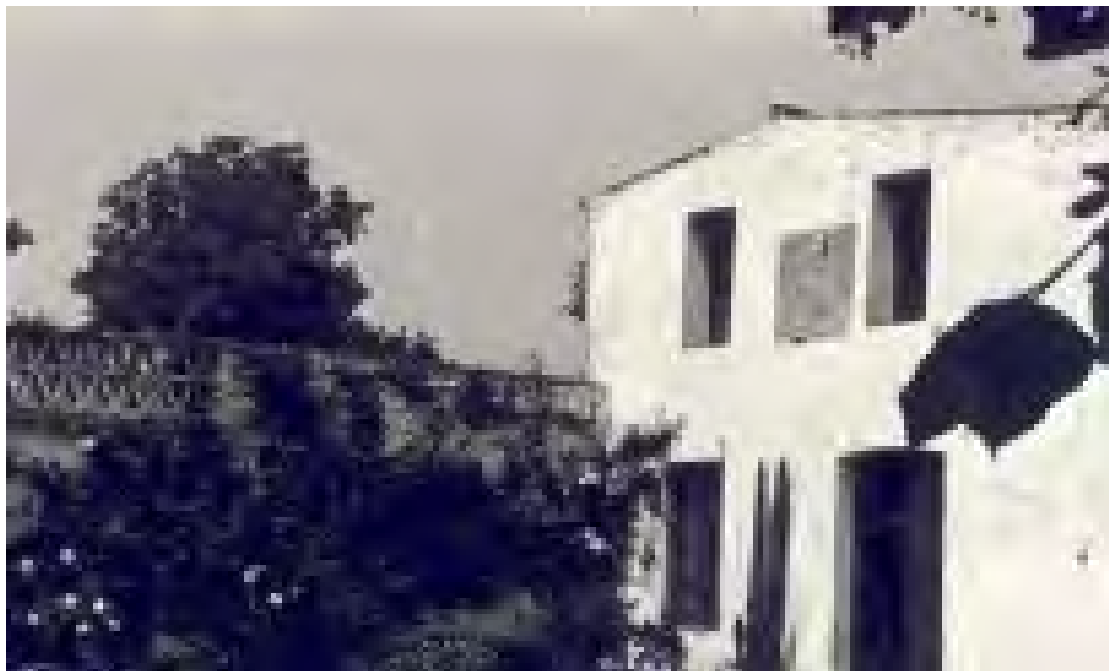
El reloj de sol de Can Barriga era doble. Entre las dos ventanas del primer piso de esta otra fachada estaba el cuadrante vertical a levante. El polo estaba desplazado hacia la derecha (obsérvese el círculo de color oscuro).
