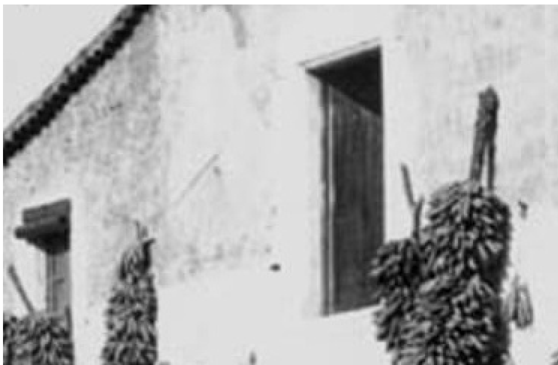
Estado del reloj de sol antes de 1914.
