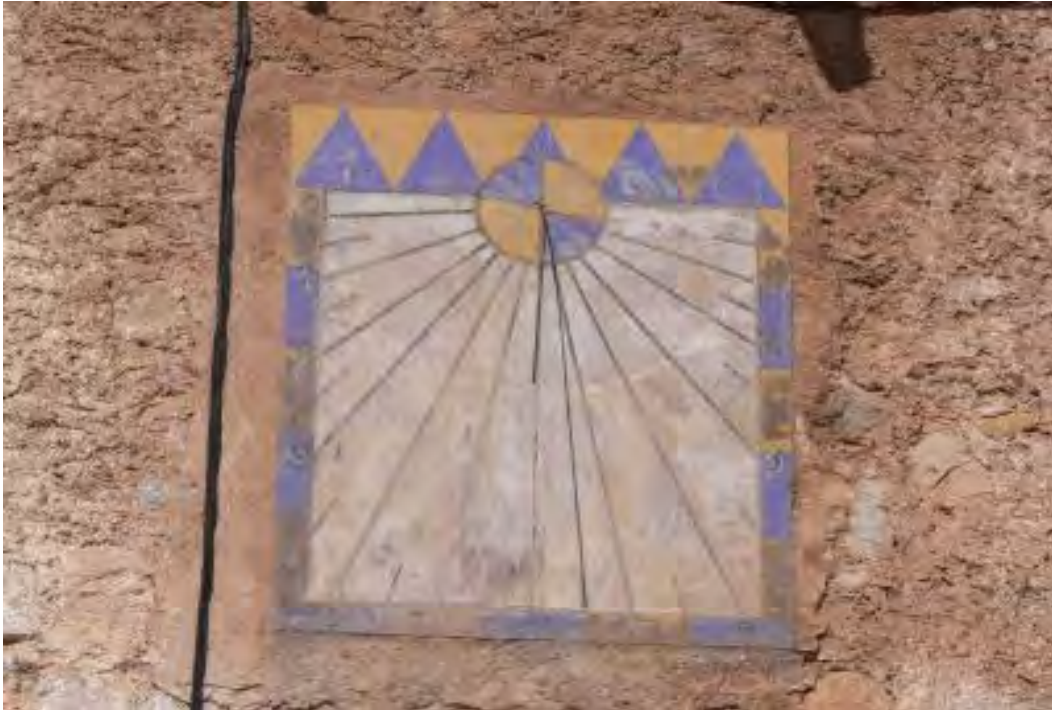
Rectangular. Marco y círculo distribuidor decorado con rectángulos y triángulos que alternan el color. VDL. Números arábigos. Medias horas. Varilla de un apoyo.
