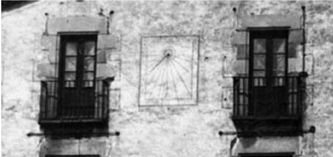
Reloj de sol doble Cuadrante declinante a levante. Rectangular. Horas en arábigos. Campanita del Ángelus. Varilla de un apoyo.
