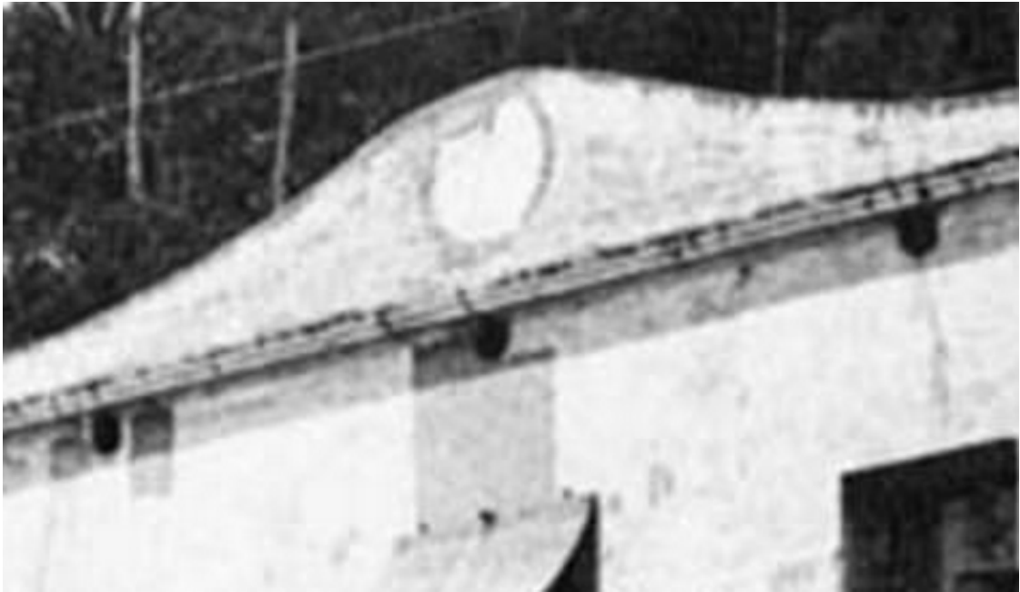
Circular. Varilla de un apoyo.
