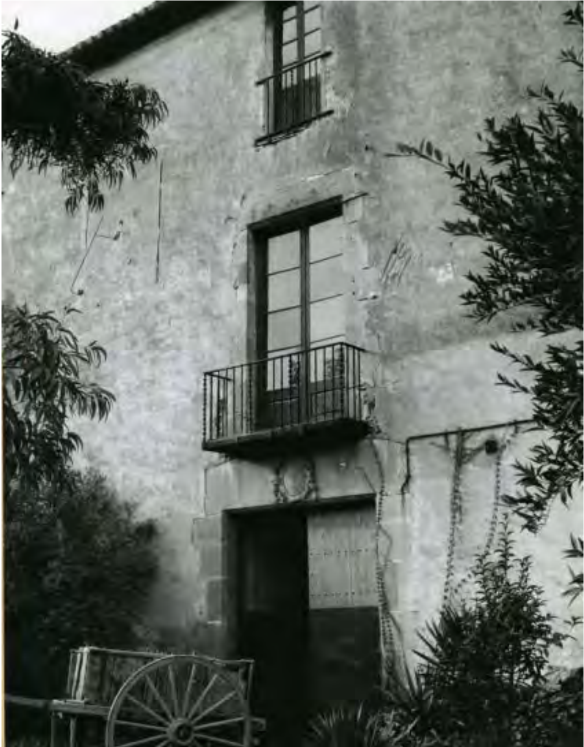
Can Clota. Esplugues de Llobregat. Baix Llobregat. 2006.
