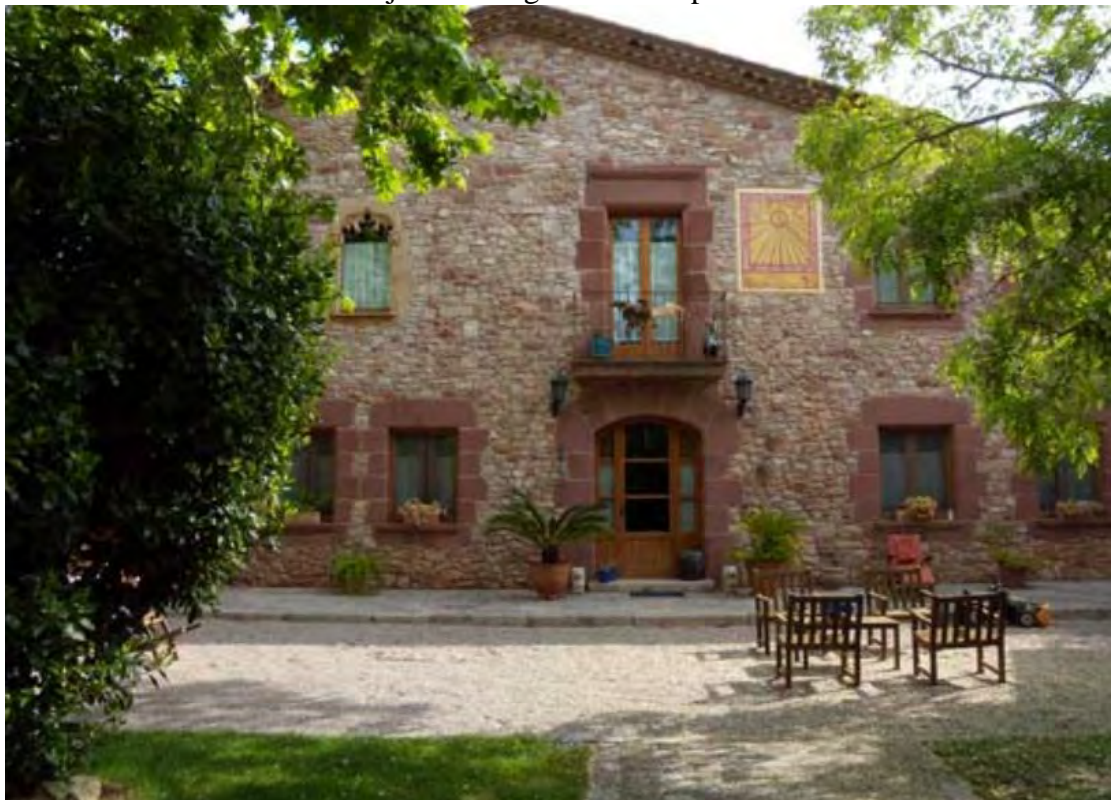
Mas Ferrer. Begues. Baix Llobregat. Pla Especial de Catàleg de masies... Begues, 2013.
