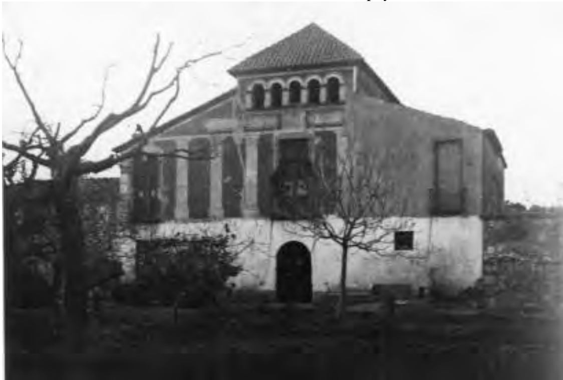
Can Raspall. Sarrià. Barcelona. Barcelonès. AFCEC Ignasi Adroer i Calafell ca. 1931. D.
