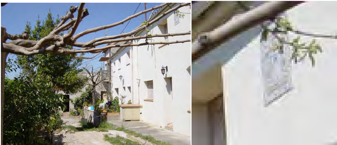
Cal Catequero. Situada a la prolongació del carrer Batllell, en un camí de terra, a uns 100 metres a mà dreta seguint el camí cap amunt.
