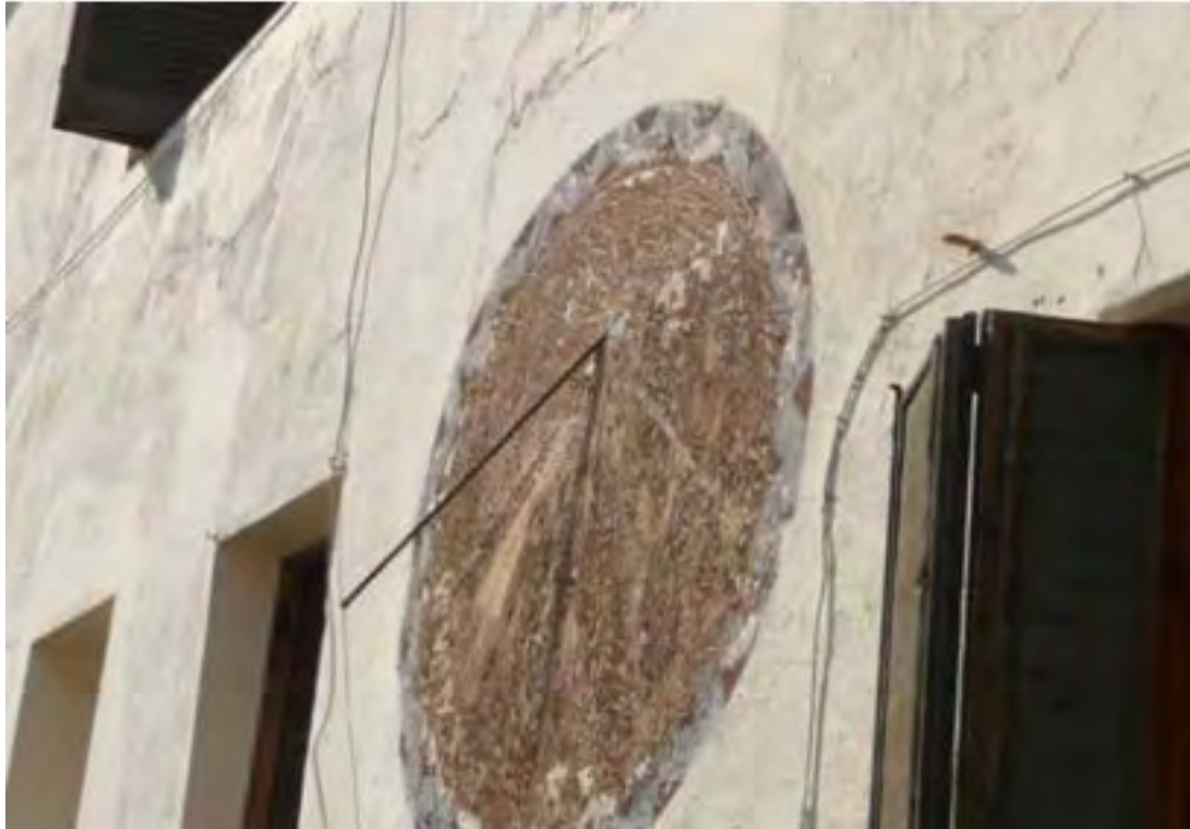
Circular. Varilla de un apoyo.
