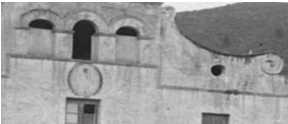
Circular. Varilla de un apoyo.
