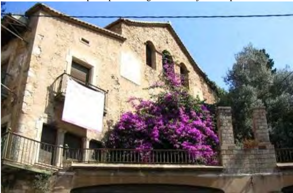
Can Mariner antes de la restauración. Relojes 1 y 2 en la fachada sureste.
