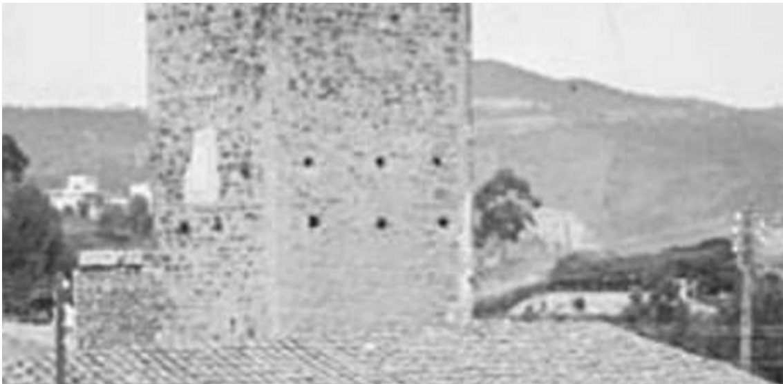
Superficie rectangular enlucida en el costado sur de la torre. Desprendimiento en la zona superior izquierda. Marco rectangular pintado.
