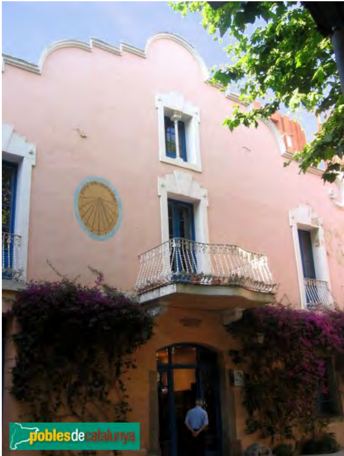
Can Brillas. Esplugues de Llobregat. Baix Llobregat. Albert Esteves 2006.
