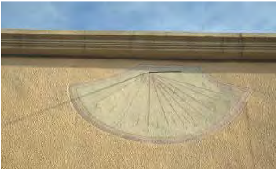
Semicircular. VDP. Polo desplazado hacia la izquierda. Horas en números romanos, de X de la mañana a VII de la tarde. Medias horas. Varilla de un apoyo.
