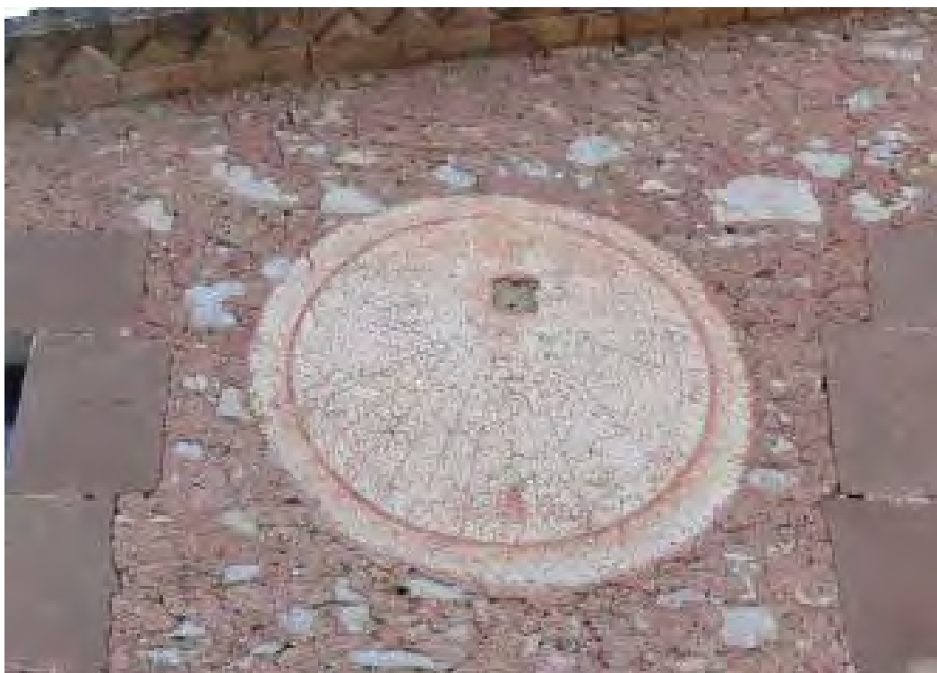
Circular. VDL. Varilla de un apoyo desaparecida. Fechado en 1815.
