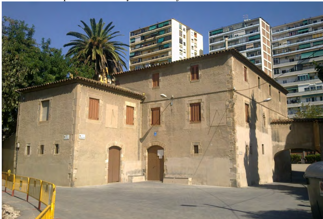
Rectoria de Sant Martí de Provençals. Barcelona. Barcelonès. PATRIMONI.GENCAT Deosringas 2012.
