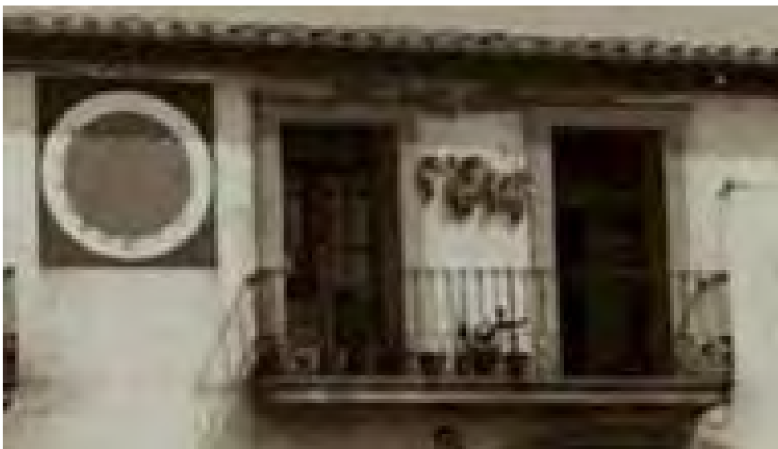
Circular inscrito en un cuadrado. Vertical declinante a levante. Números árabigos. Varilla de un apoyo.
