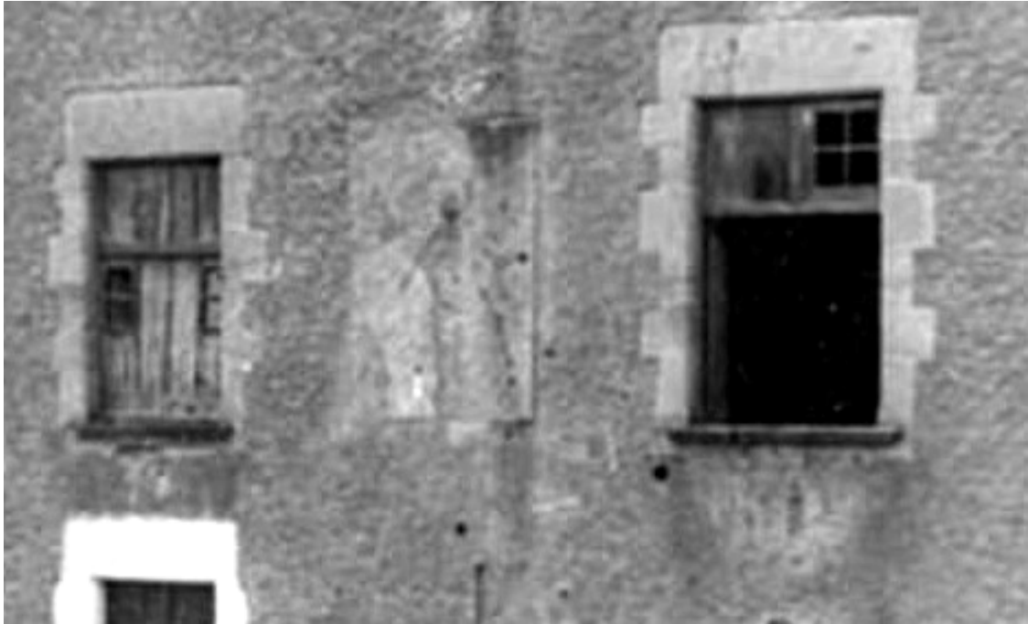
En un esquinale de la torre, a la altura de la segunda planta. Rectangular. Vertical declinante a levante. Varilla de un apoyo.
