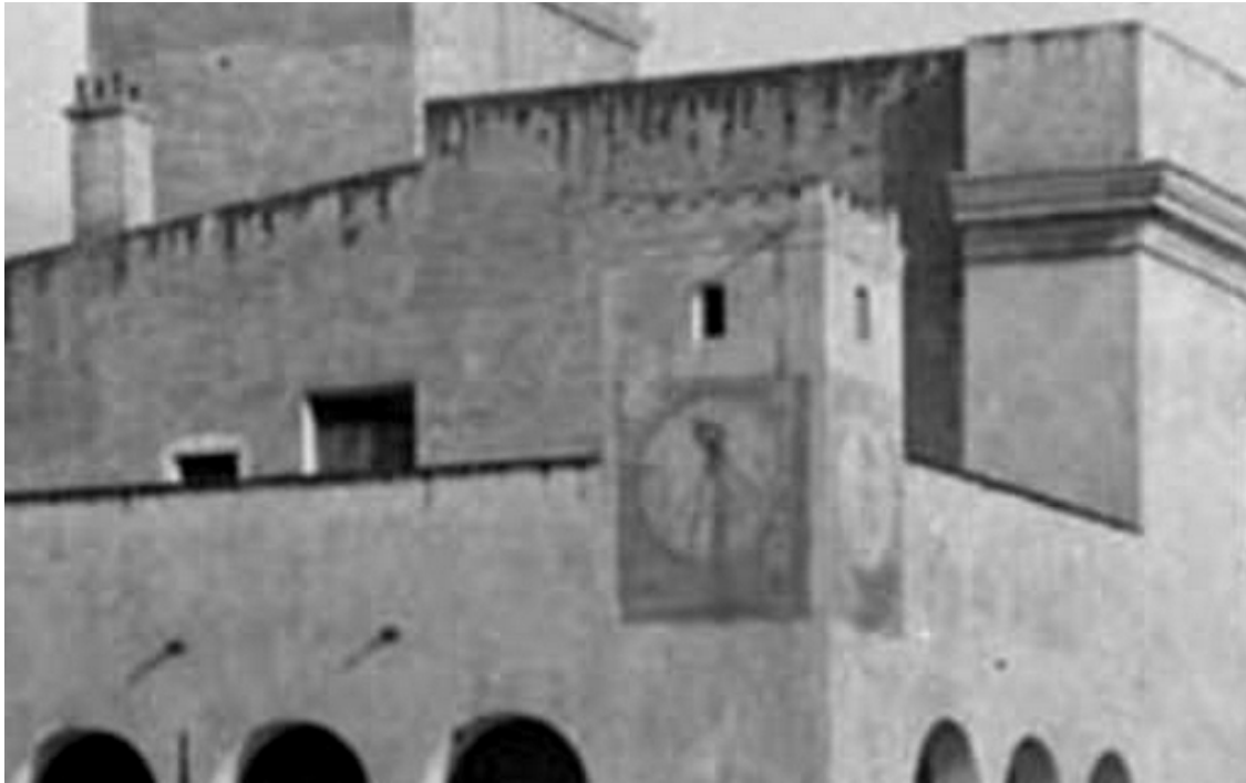
Reloj de sol doble. Ovalados dentro de un rectángulo. VDL y VDP.
