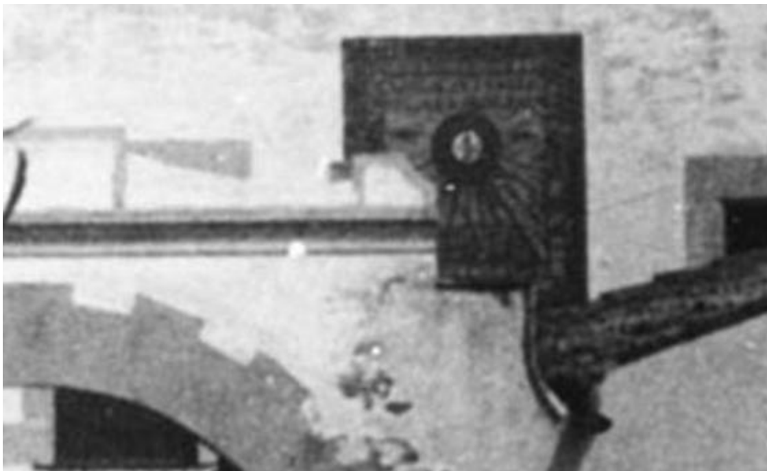
Rectángulo. Vertical declinante a poniente. Horas en números arábigos, de 8 de la mañana a 6 de la tarde. Líneas de medias horas. Varilla de un apoyo.
