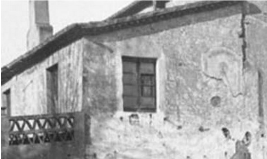
Reloj de sol doble. El de la fachada principal ha perdido la mitad de la placa.
