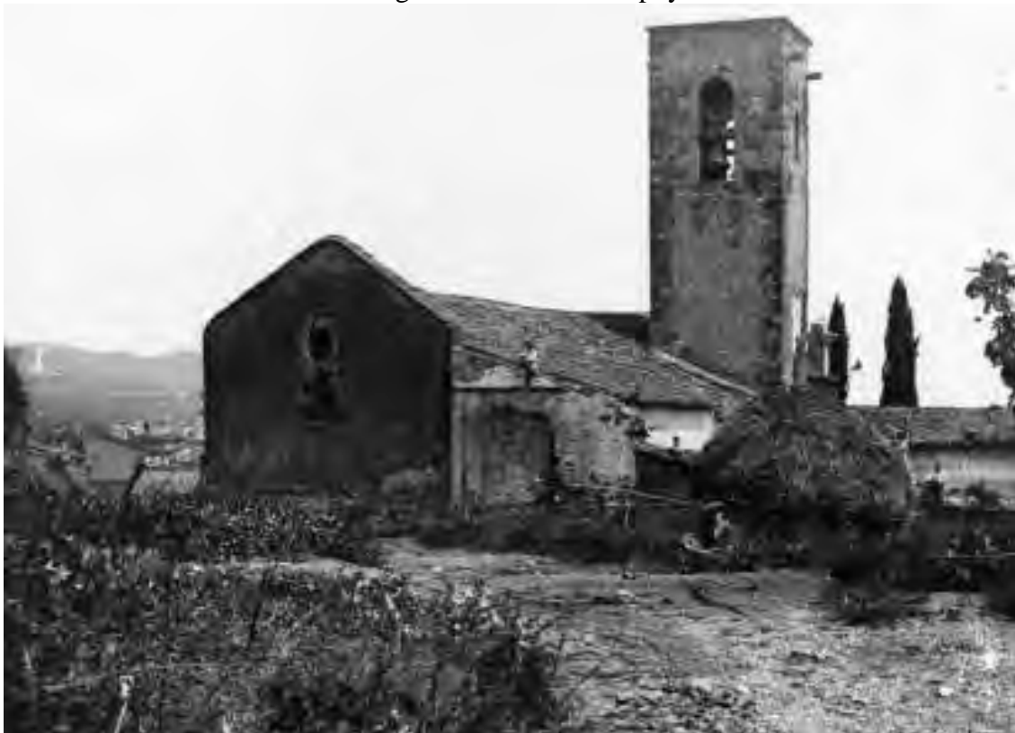
Església de Santa Coloma de Cervelló. Baix Llobregat. AFCEC J. Estorch. 1921-1936. D.
