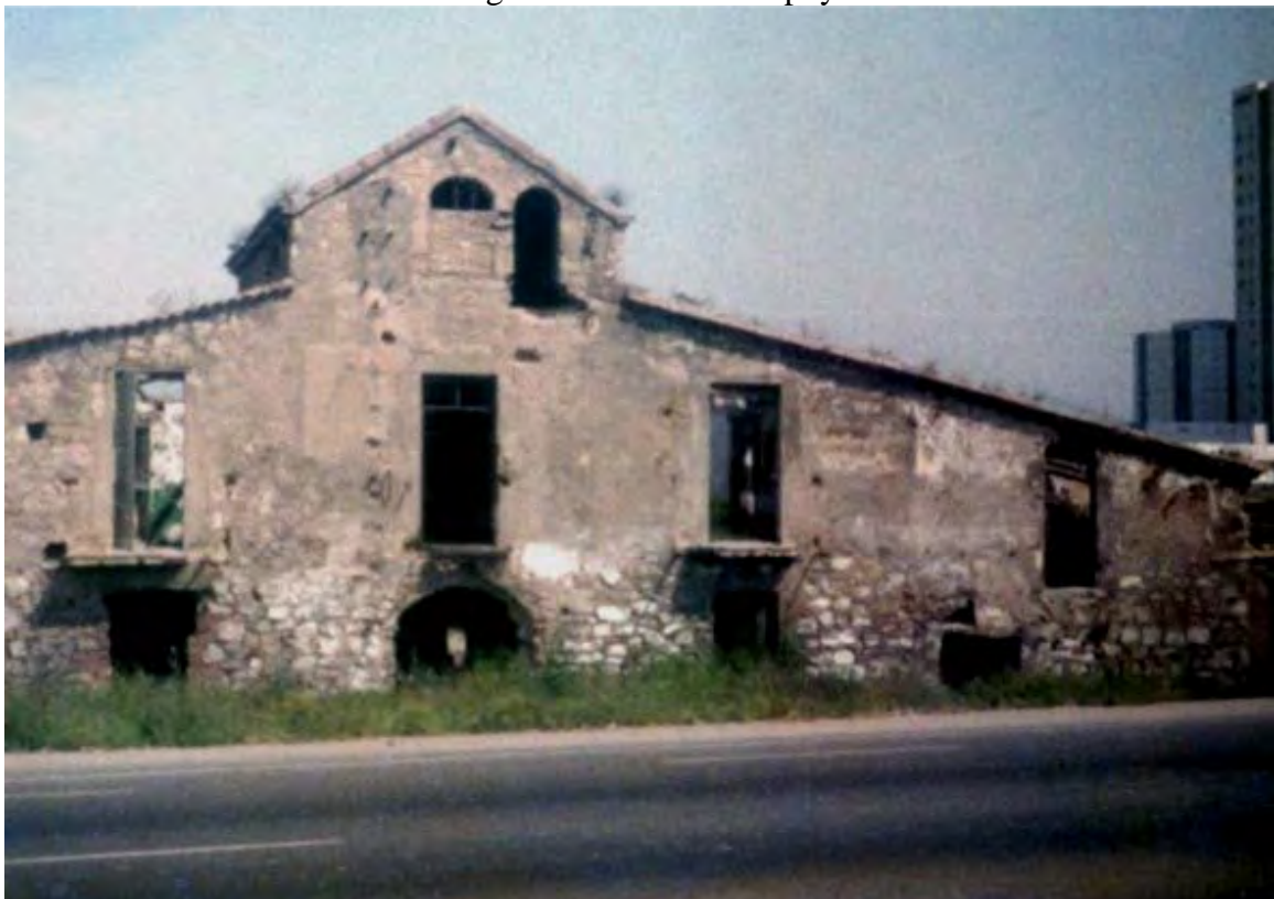
Cal Xic de la Barca. L'Hospitalet de Llobregat. Barcelonès. D.
