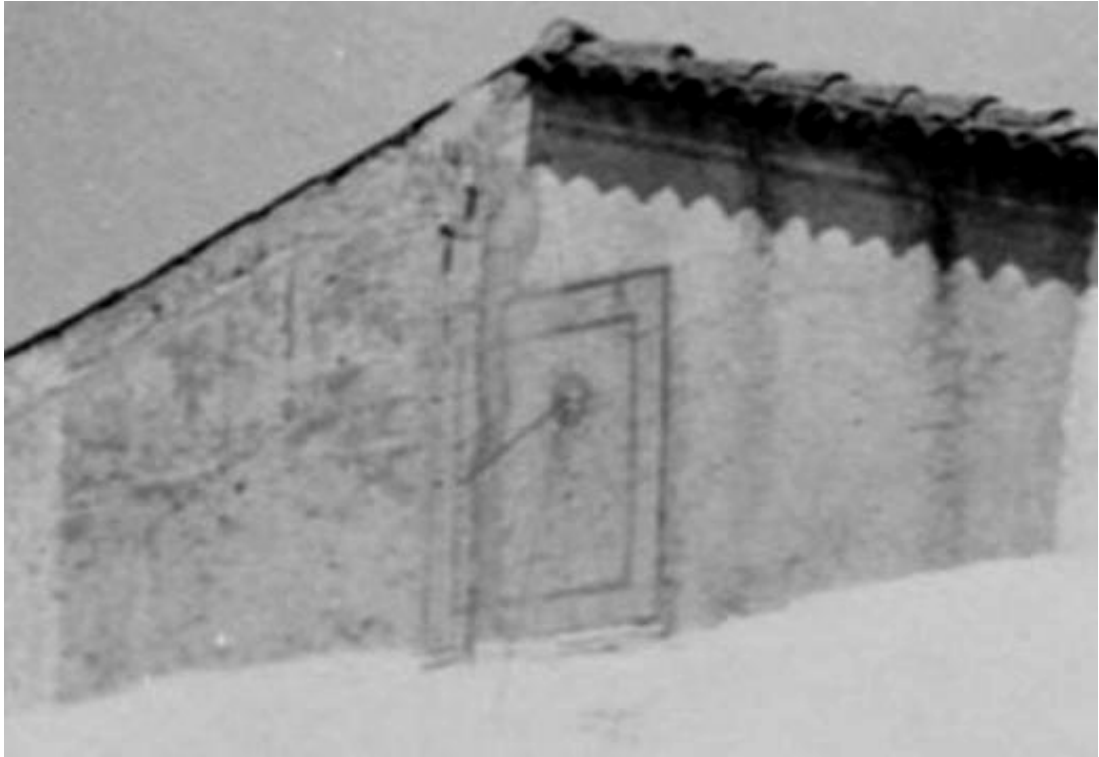
Rectangular. Polo desplazado hacia la derecha. VDL. Varilla de un apoyo. Se ha blanqueado toda la fachada excepto la zona del reloj de sol.
