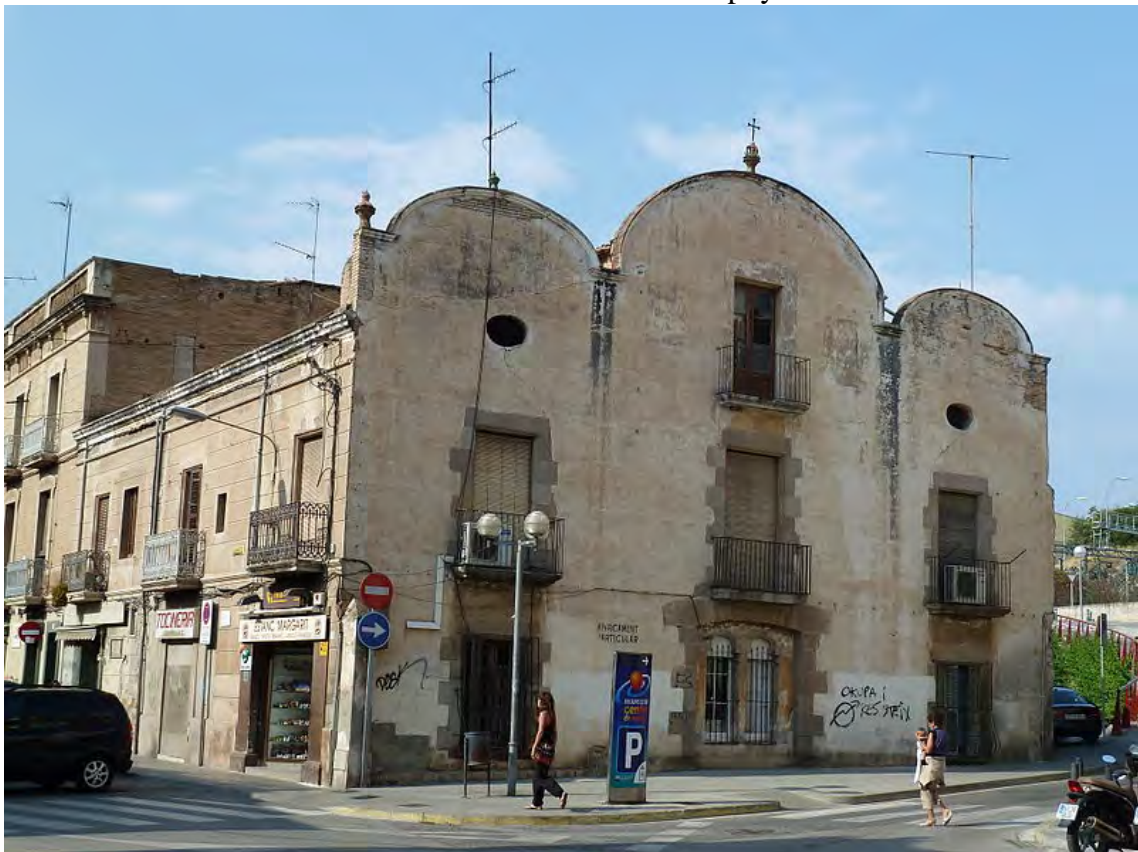
Can Roca. Molins de Rei. Baix Llobregat. PATRIMONI.GENCAT Deosingas 2012.
