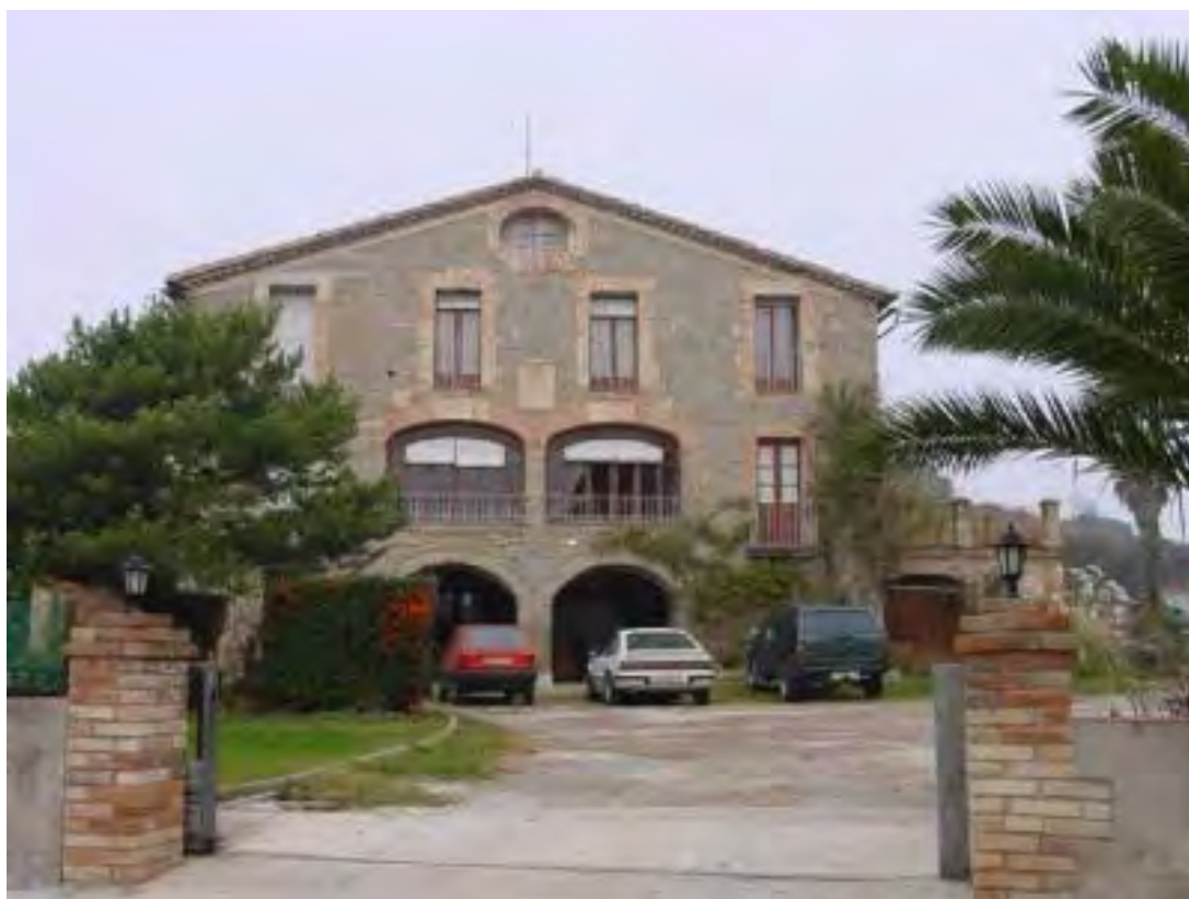
Can Mas Nou. Abrera. Baix Llobregat. DIBA Mapes de Patrimoni Cultural 08011/11.
