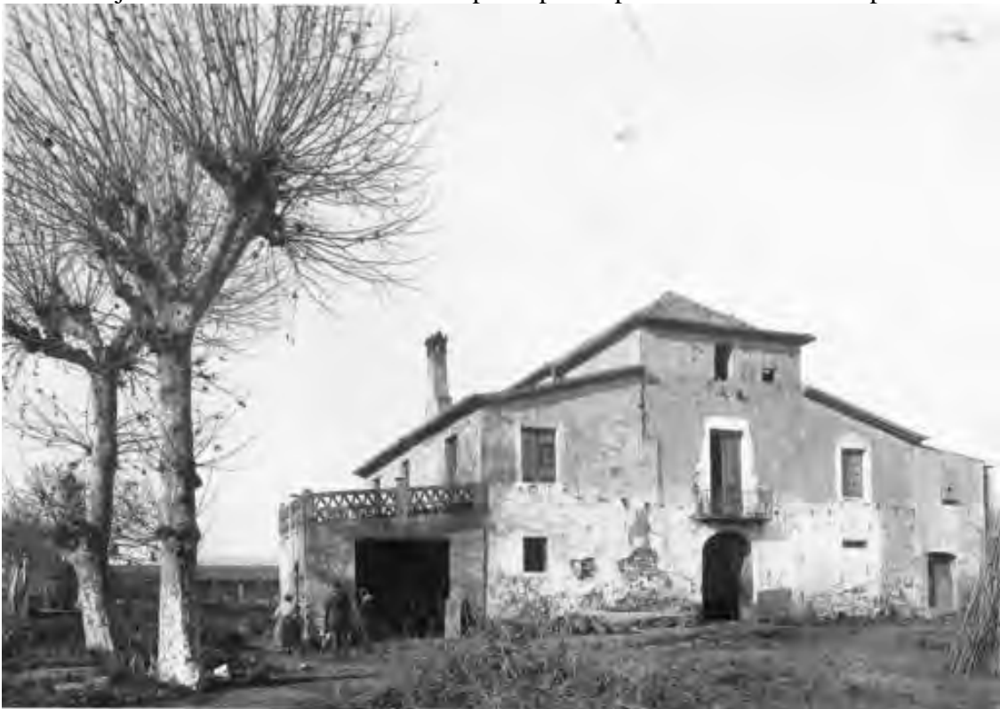
Can Pujol. Sant Martí de Provençals. Barcelona. Barcelonès. AFCEC 1914. D.
