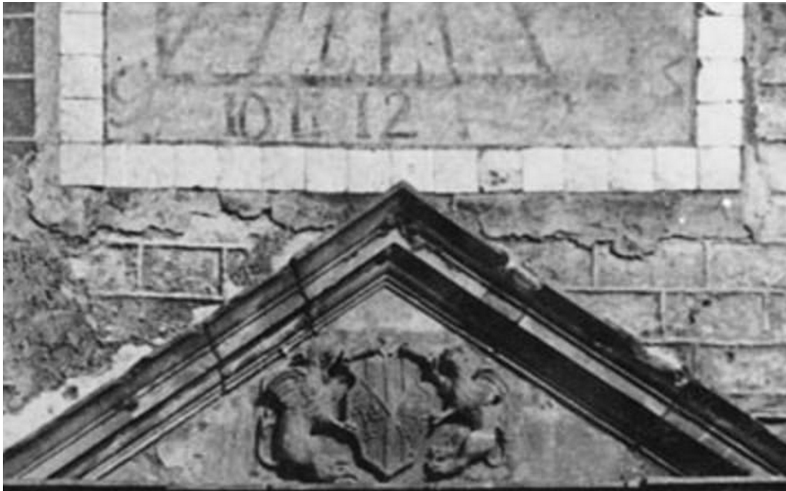
Marco cerámico. VDL. medias horas. Numerado en arábigos.
