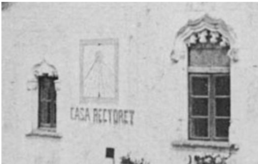
Rectangular. Vertical declinante a levante. Campanita del Àngelus. Varilla de un apoyo. Inscripció: CASA RECTORET.
