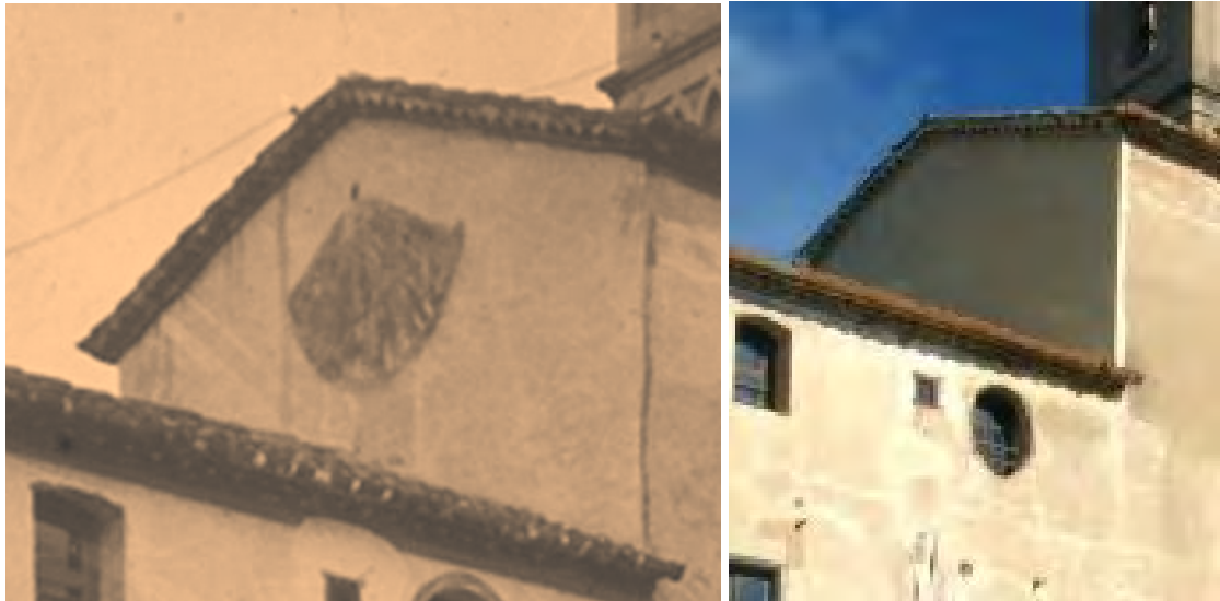
Fachada lateral sobre el tejado del ala sur del claustro. Desaparecido.
