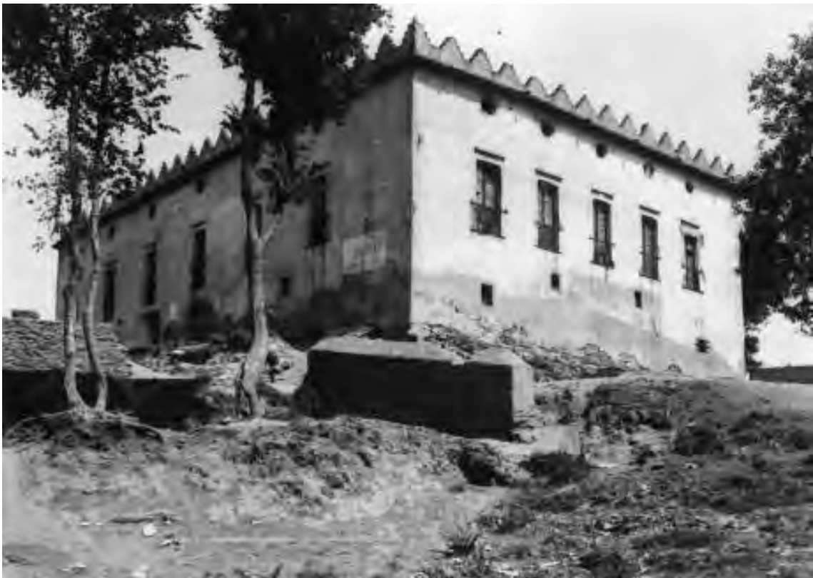
Can Paixau. Llefia. Badalona. Barcelonès. AFCEC 1930. ¿Reloj? Can Paixau. Situació: Barri de Llefia.
