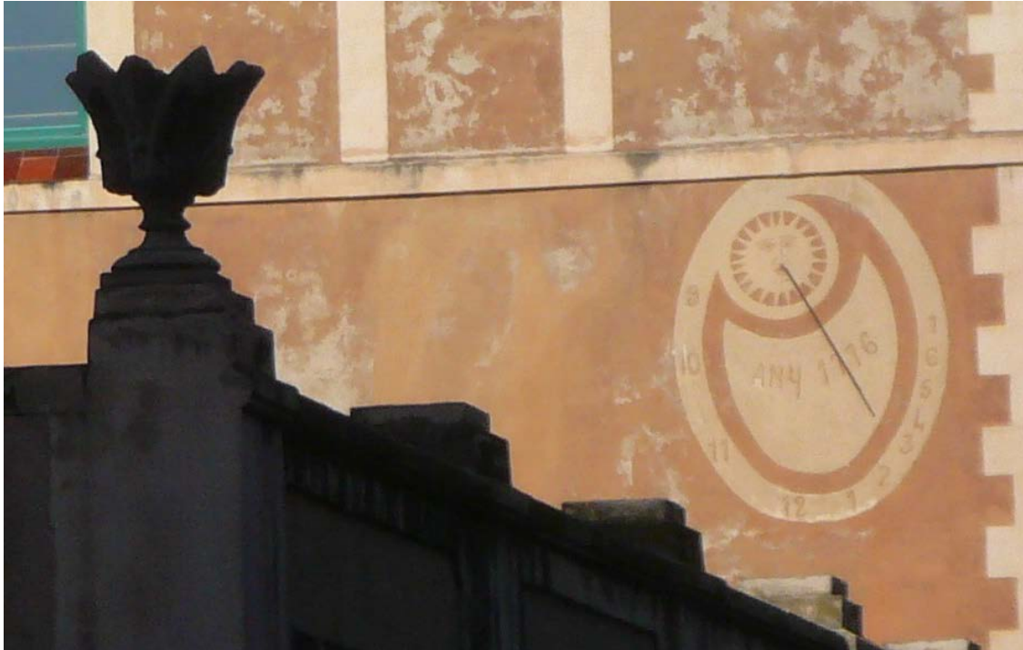
Ovalado. Polo desplazado hacia la izquierda. VDP. Horas en números arábigos, de 9 de la mañana 7 de la tarde. Varilla de un apoyo. Inscripción de fecha: ANY 1776.
