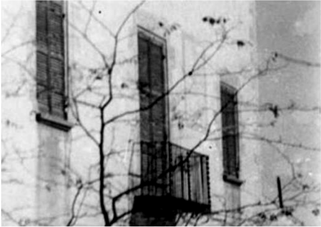
Rectangular. Varilla de un apoyo. Derribada.
