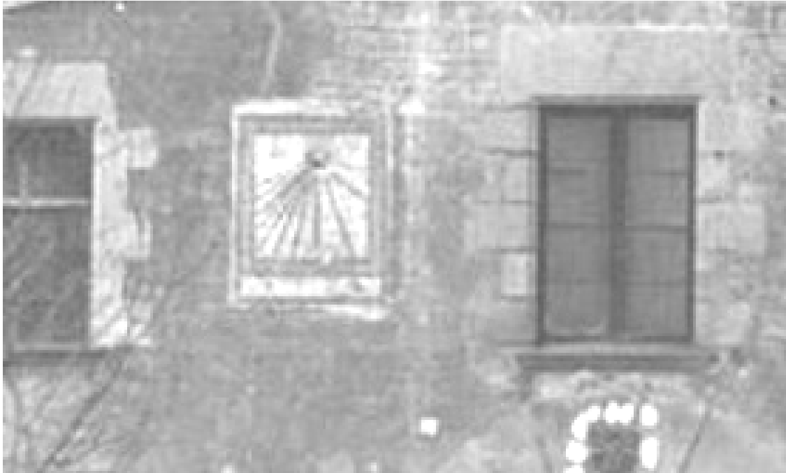
Rectangular. Cartela inferior. polo desplazado hacia la derecha. Vertical declinante a levante. Varilla de un apoyo.
